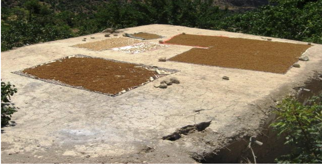
Fotoğraf 11. Kırsal yerleşmelerde geçmişten bu yana konutların çatı örtü tipi çoğunlukla toprak düz dam şeklinde yapılmıştır. Zamanla betonarme evlerin yapılması ile birlikte çatılar betonarme düz dam olarak örtülmeye başlanmıştır (Kaşlıca Köyü, Fatma Önal-2012).
