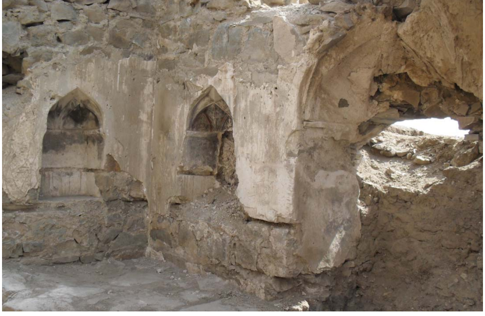
Foto 90: Harem, Güneydoğu Odası Doğu Duvarında Yer Alan, Kuzeydoğu Köşesindeki Mukarnas Kavsaralı Niş.
