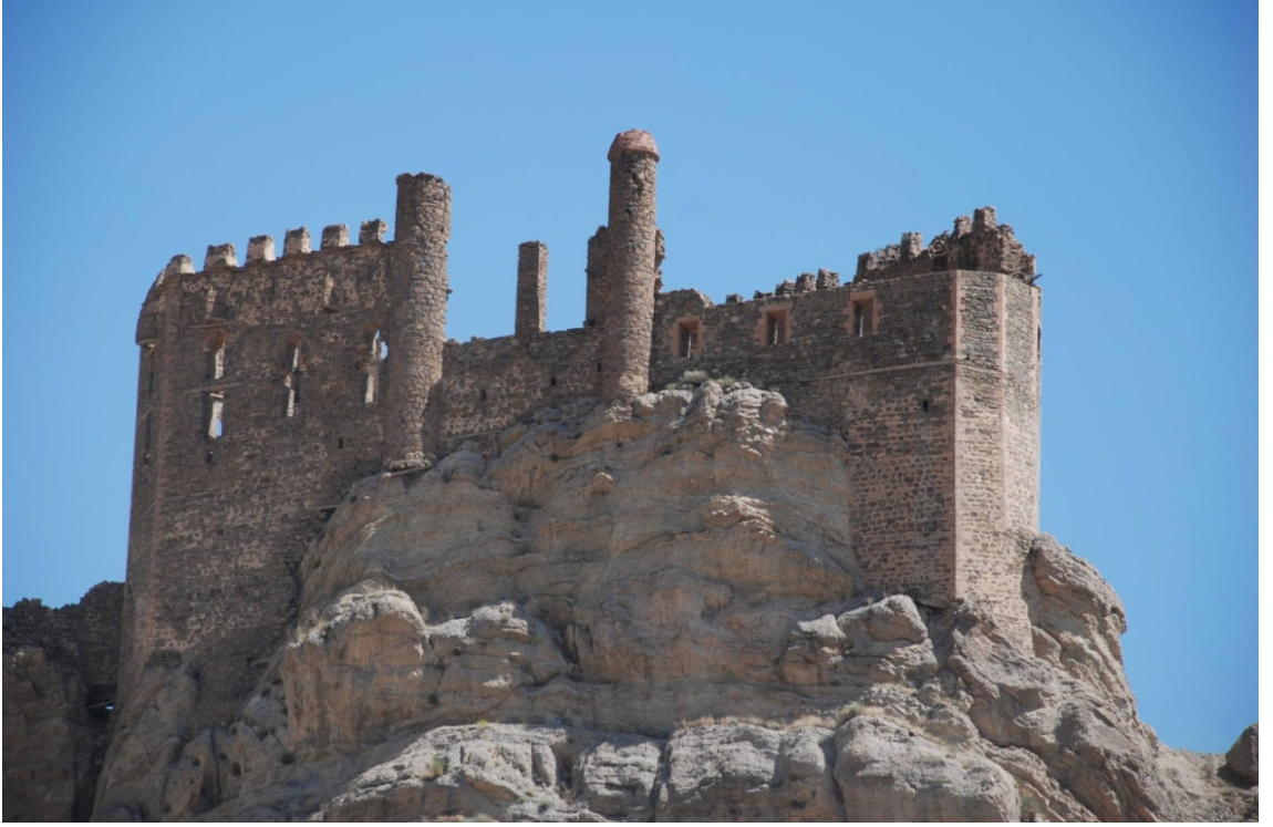
Foto4: Seyir Köşkü Güneyden Görünüşü
