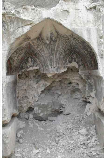
Foto 91: Harem, Güneydoğu Odası Doğu Duvarında Yer Alan, Kuzeydoğu Köşesindeki Mukarnas Kavsaralı Niş.
