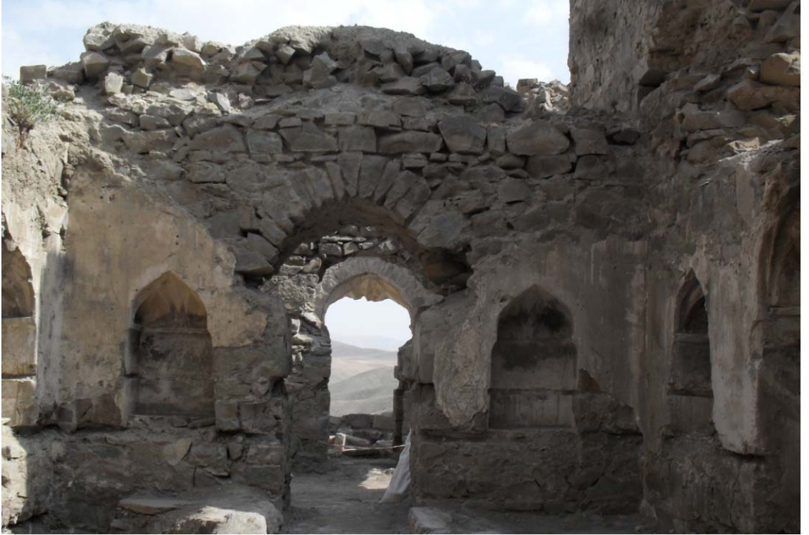
Foto 86: Harem, Güneydoğu Odası Giriş Kapısı
