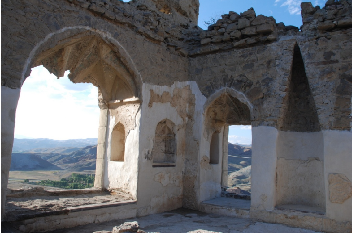
Foto 39: Harem Kuzeybatı Odası Kuzey ve Batı Duvarı
