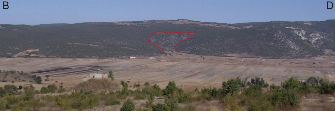
Şekil 4.7 Havza kuzeyindeki heyelan alanı (G'den bakış)
