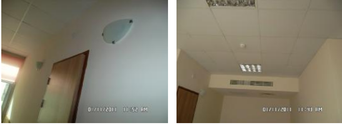
A) Hasta odası duvar aydınlatması
