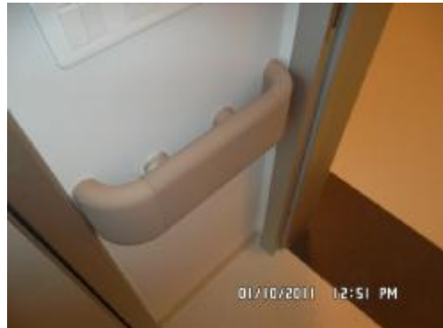
Şekil 81. Güney Toros Hastanesi hasta katı standart hasta odası duvar koruyucu bant
