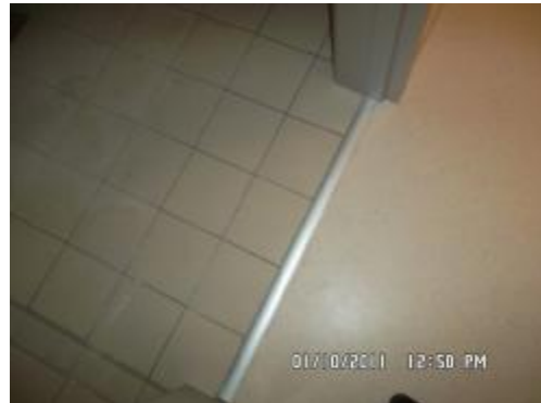
C) Zemin döşemesi
