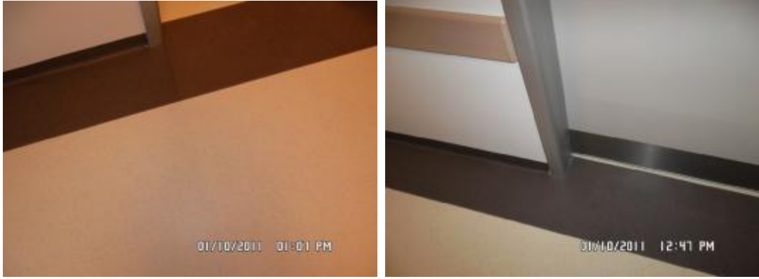
Şekil 74 Güney Toros Hastanesi (EPC) hasta katı zemin döşemesi ve laminat kapı
