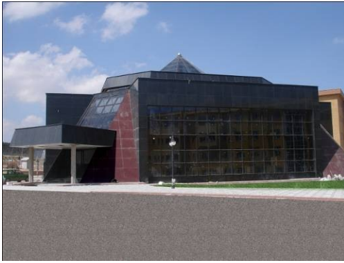
Şekil 6.32. a) Kafeterya binası
