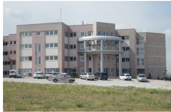
b) Teknokent binası
