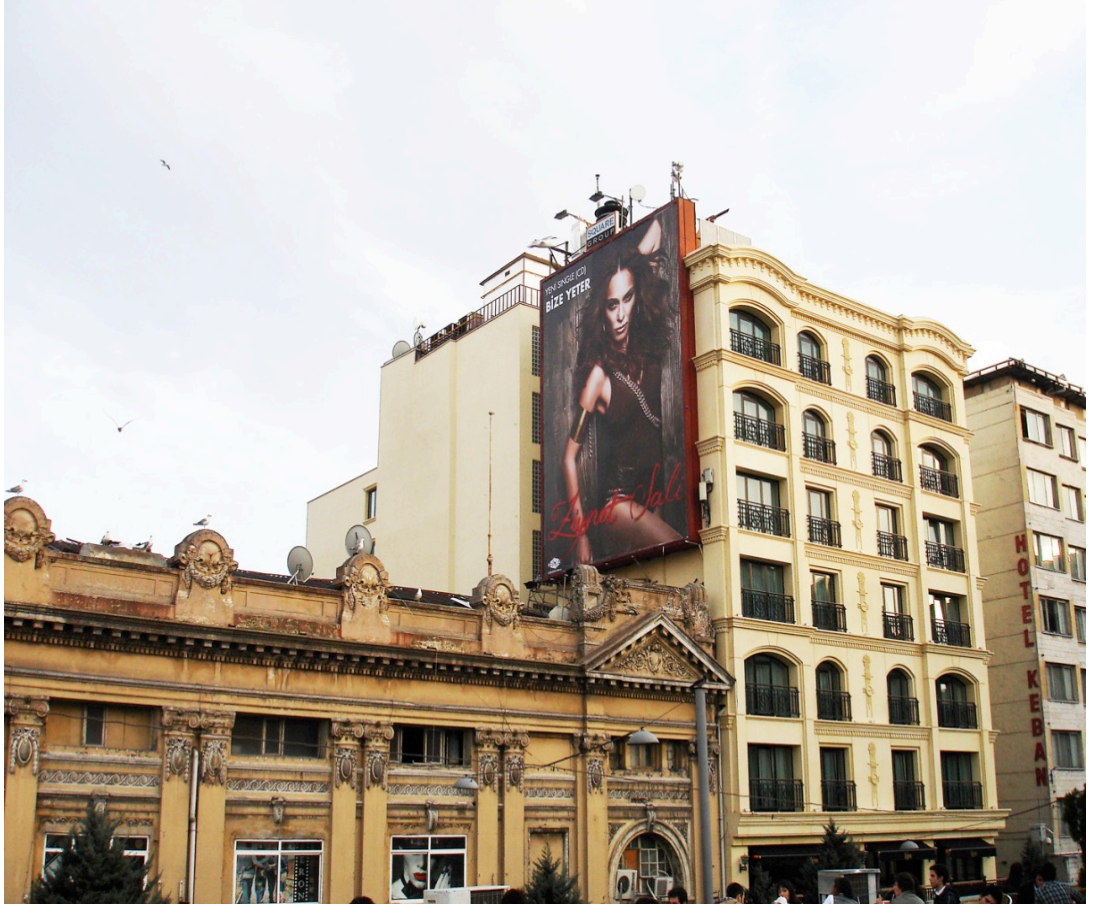
Şekil 5.62: Bina Sağır Duvarı Üzeri Vinily Uygulama Örneği, İstanbul.
