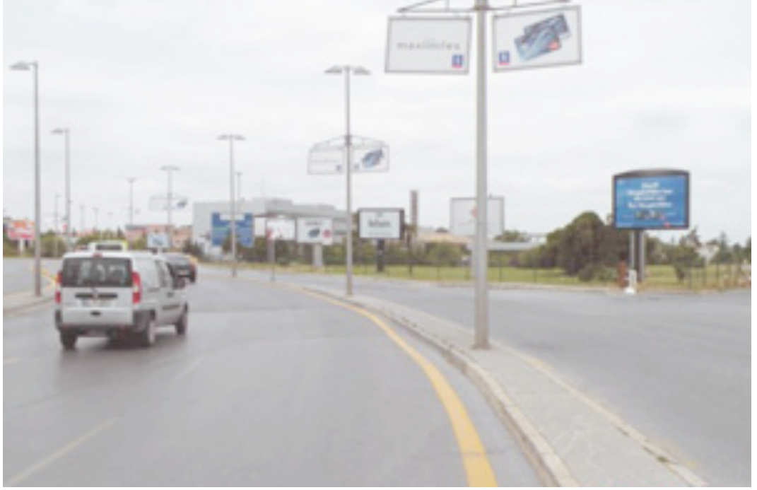
Şekil 5.24: Elektrik Direkleri Üzeri Uygulama Örneği.
