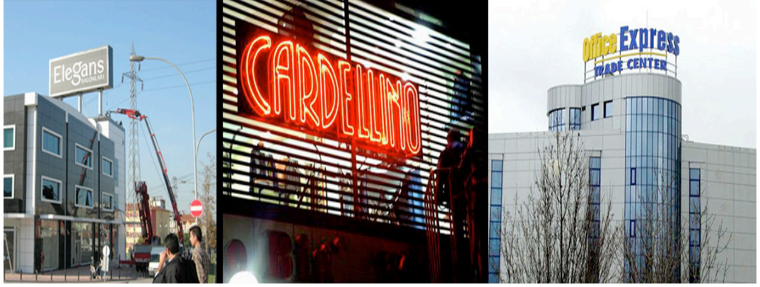
Şekil 5.29: Bina Çatı Üzeri Tabela Uygulamaları.
