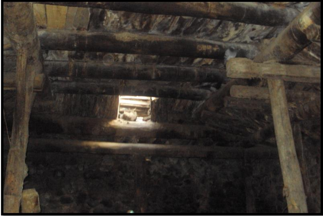
Şekil 4.4. Araştırma konusu barınaklardan birinin havalandırma bacası
