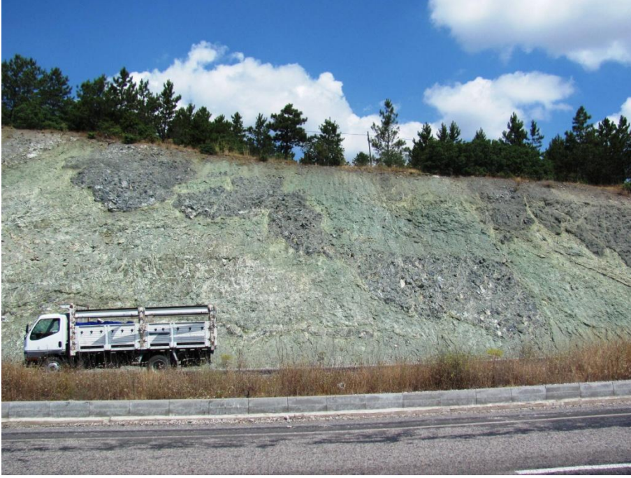
Şekil 4.7. Kütahya-Tavşanlı karayolu üzerindeki büyük kireçtaşı blokları içeren serpantinitleten genel görünüm (35S 0723890D/4379169K, 958m,Bakış yönü: B'dan D'ya doğru).
