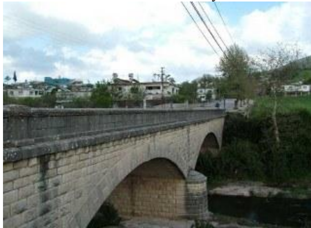
Ek 11 : Dibitçe Köprüsü
