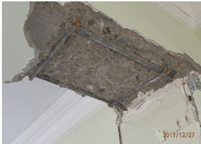
Şekil 6.9 : K116 kirişi sağ mesnet alt donatısı.
