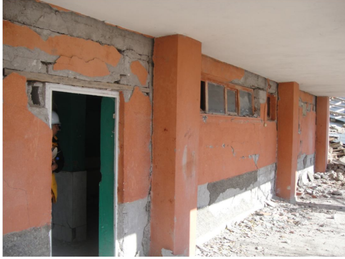
Şekil 6.30 : Zemin kat doğu cephesindeki dış duvarlar-2.
