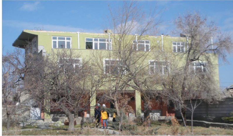
Şekil 6.5 : Doğu cephesinden görünüm.
