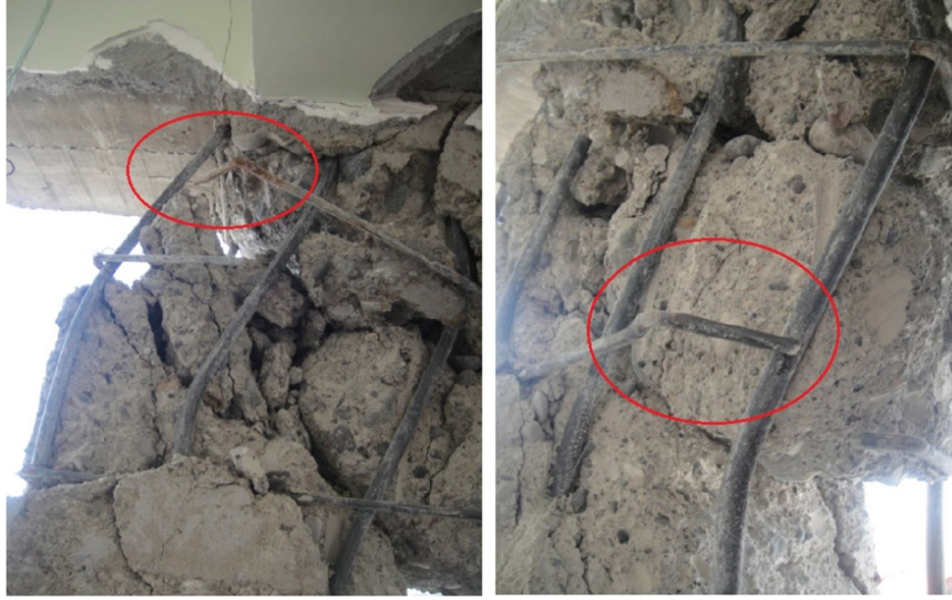
Şekil 6.11 : 10cm'den kısa ve 90° bükülen kancaların gösterimi.
