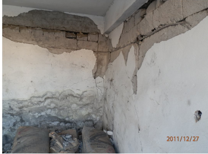
Şekil 6.32 : Zemin kat batı cephesindeki odaların iç duvarları-2.
