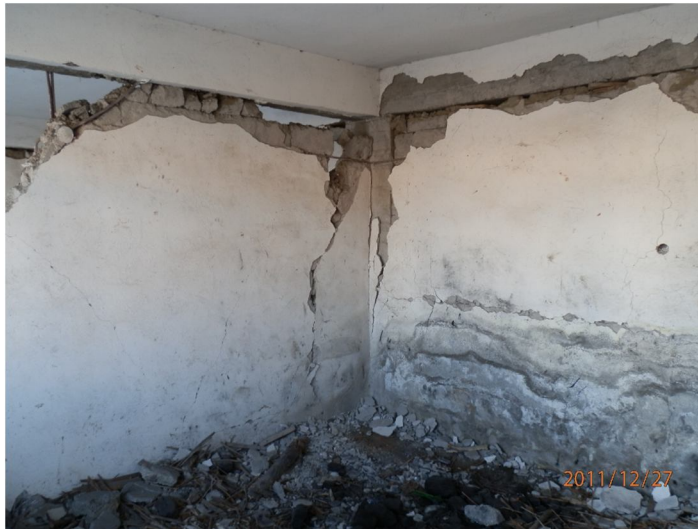
Şekil 6.31 : Zemin kat batı cephesindeki odaların iç duvarları-1.
