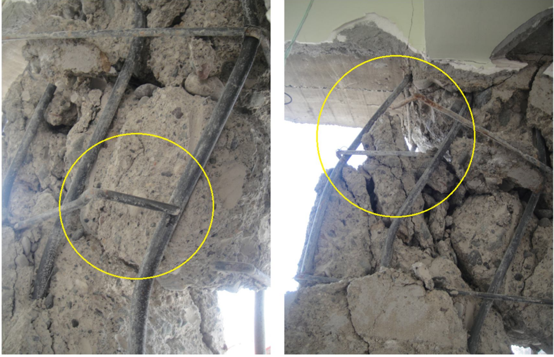
Şekil 6.17 : S114 kolonunda açılan etriyeler.
