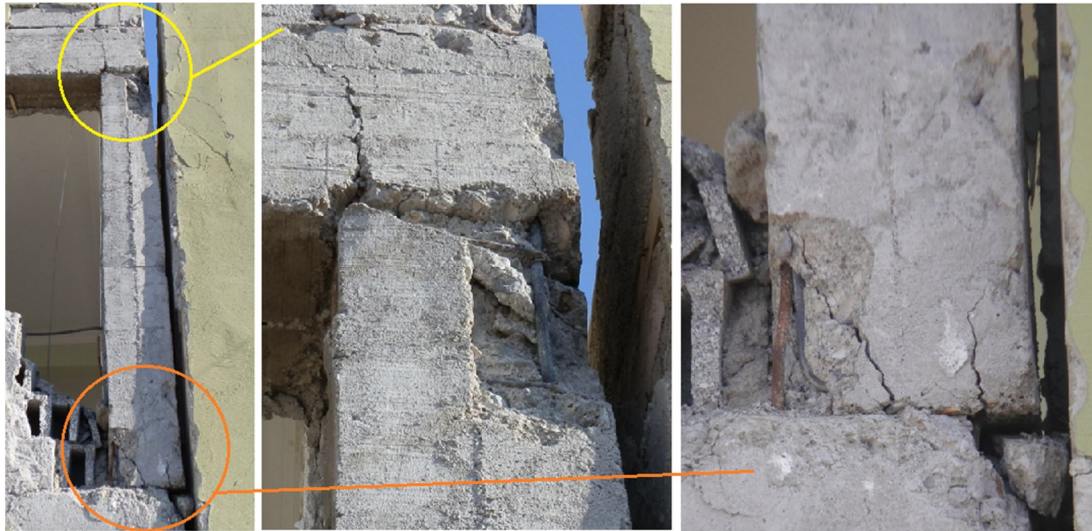
Şekil 6.26 : S115 Kolonu alt ve üst ucu donatı burkulması.
