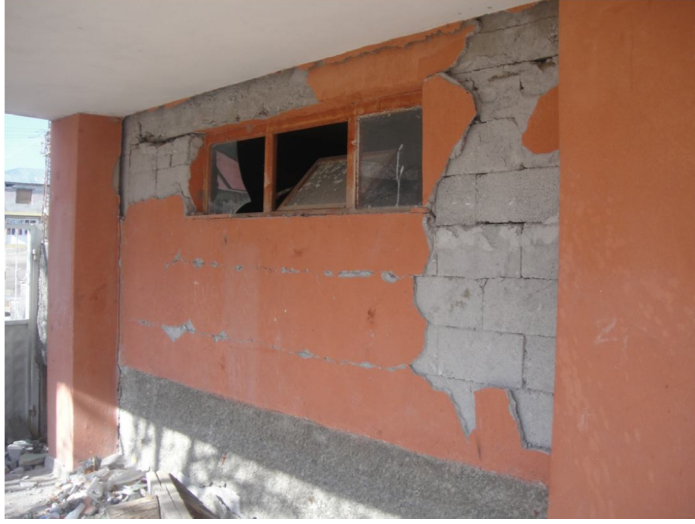
Şekil 6.29 : Zemin kat doğu cephesindeki dış duvarlar-1.
