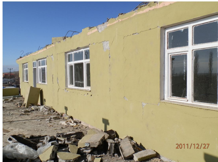
Şekil 6.37 : 2.Normal kat doğu cephesindeki dış duvarlar.
