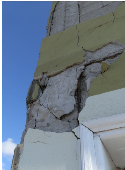
Şekil 6.21 : S113 Kolonu birleşim bölgesi.
