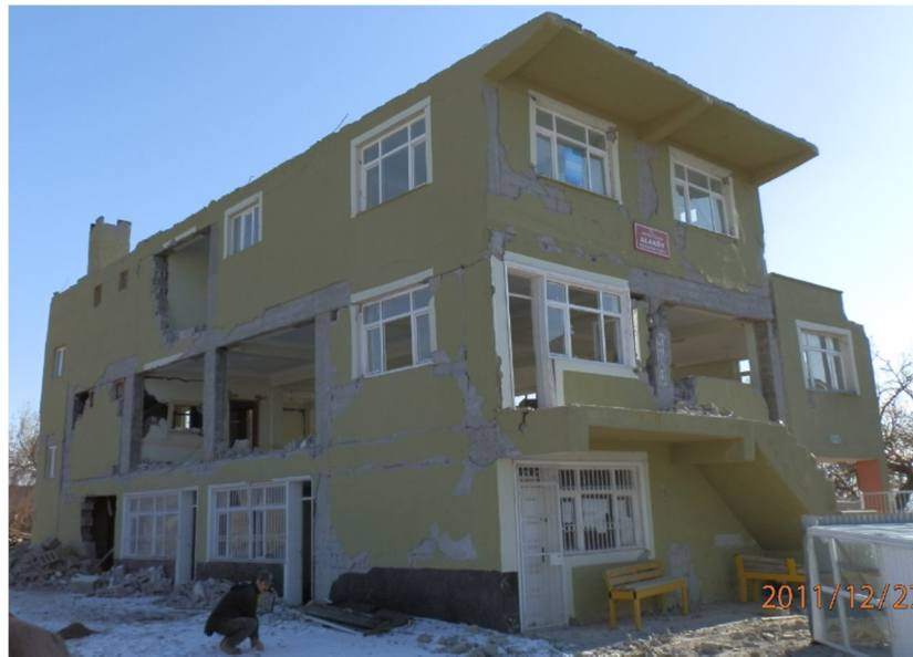
Şekil 6.28 : Dış duvarların görünümü.
