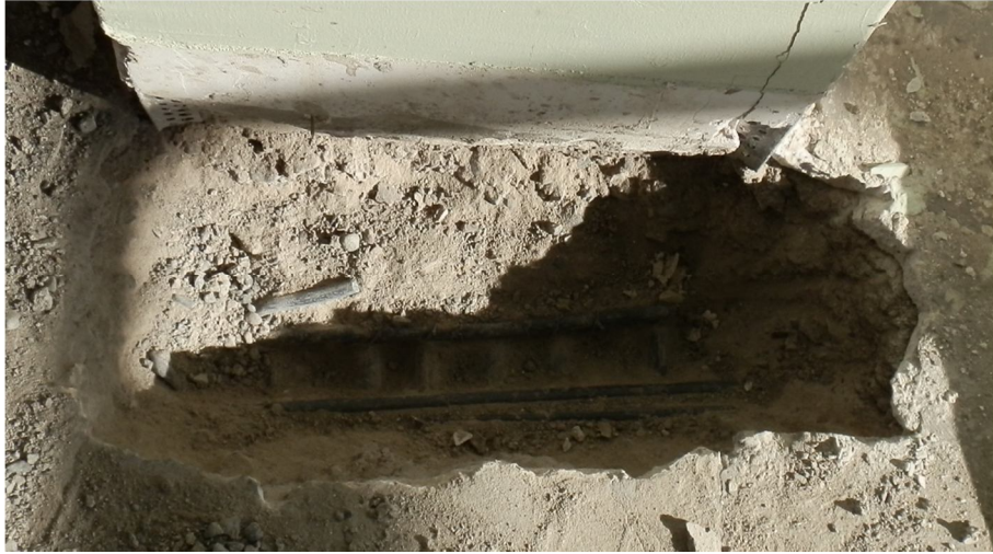
Şekil 6.8 : K116 kirişi sağ mesnet üst donatısı.
