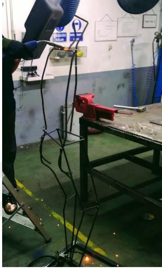
Şekil 193- İskelet Yapım Aşaması; kaynak tekniği ile biçimlendirme, Atık Demir, Hugo Boss Firması, Metal Atölyesi, Sibel Armağan Benek, 2019
