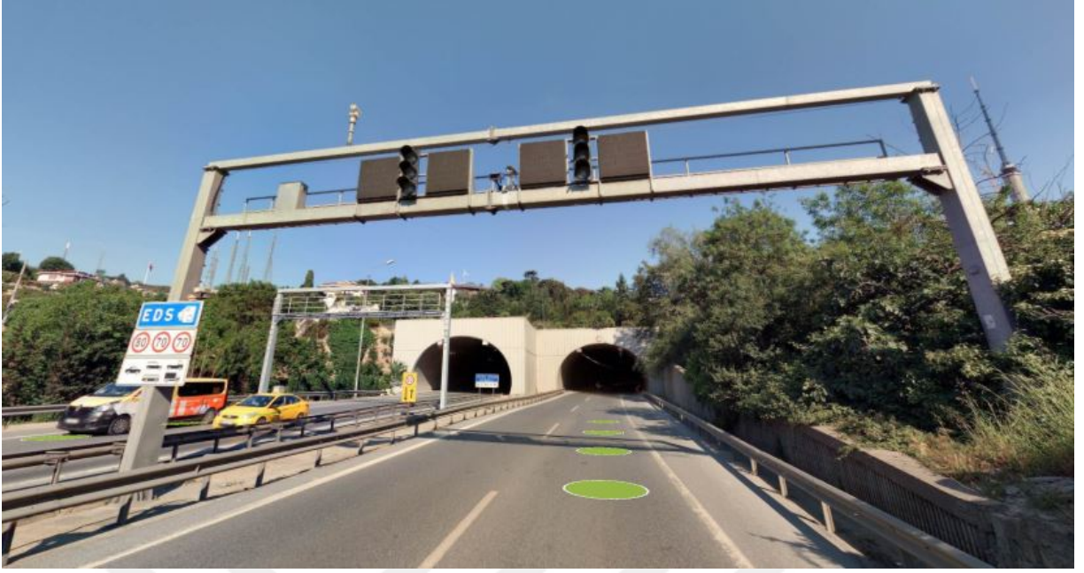
Şekil 3.13: Tünel Girişinde Bulunan DMİ Yapısı.
