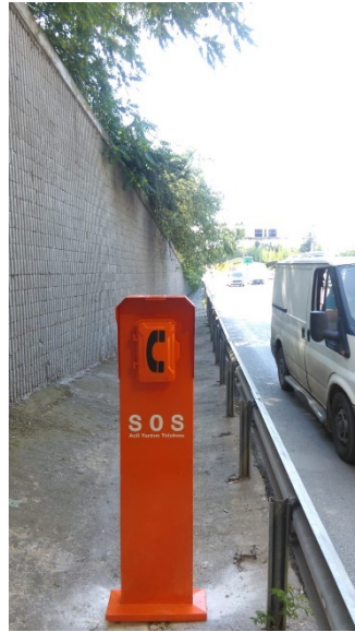
Şekil 3.16: Tünel Girişinde Kullanılan Acil Durum Sistemi.
