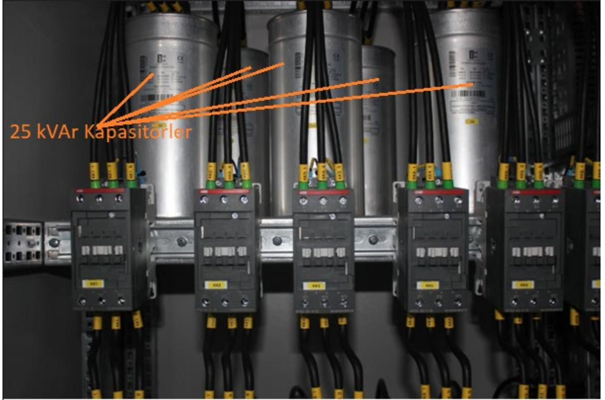
Şekil 4.3: Kompanzasyon Panosundaki Kapasitörlerin Gösterimi.
