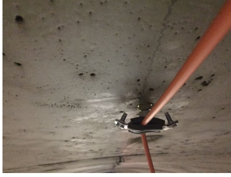
Şekil 3.11: Tüneldeki Yangın Algılama Sistemi Sensor Kablosunun Gösterimi.
