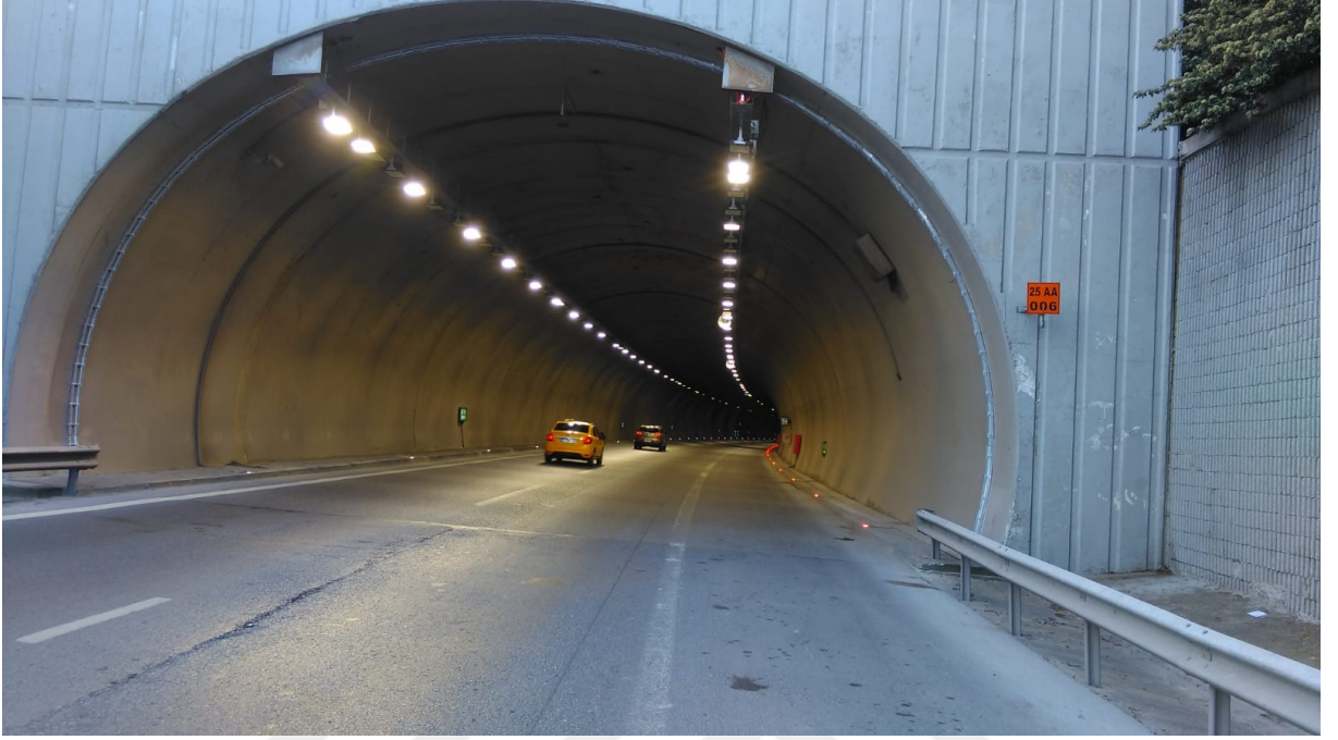
Şekil 3.9: Tünelin Ümraniye Giriş Kısmı.
