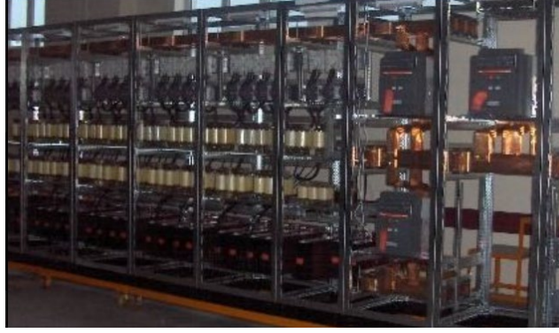
Şekil 2.16: Harmonik Filtreli Kompanzasyon Panosu.
