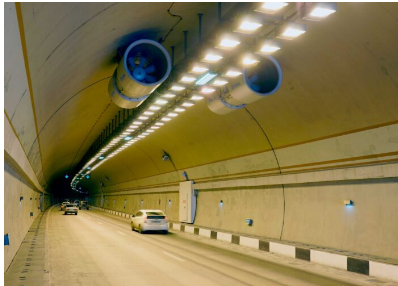
Şekil 3.17: Bir Tünelde Kullanılan Jet Fan Gösterimi [47].
