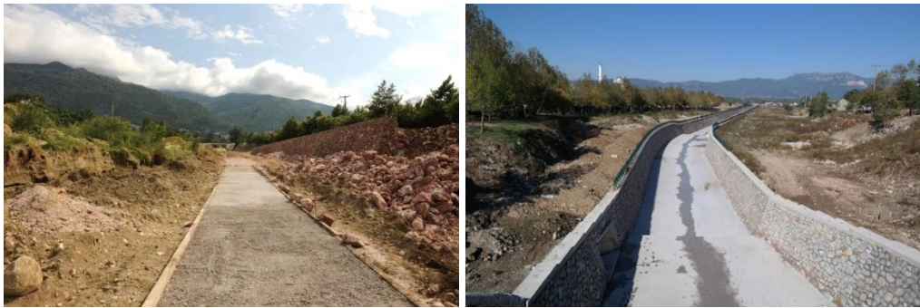
Şekil 3.27 : Hacivat Deresi yatağı düzenleme çalışmaları (Bursa Büyükşehir Belediyesi, 2012).
