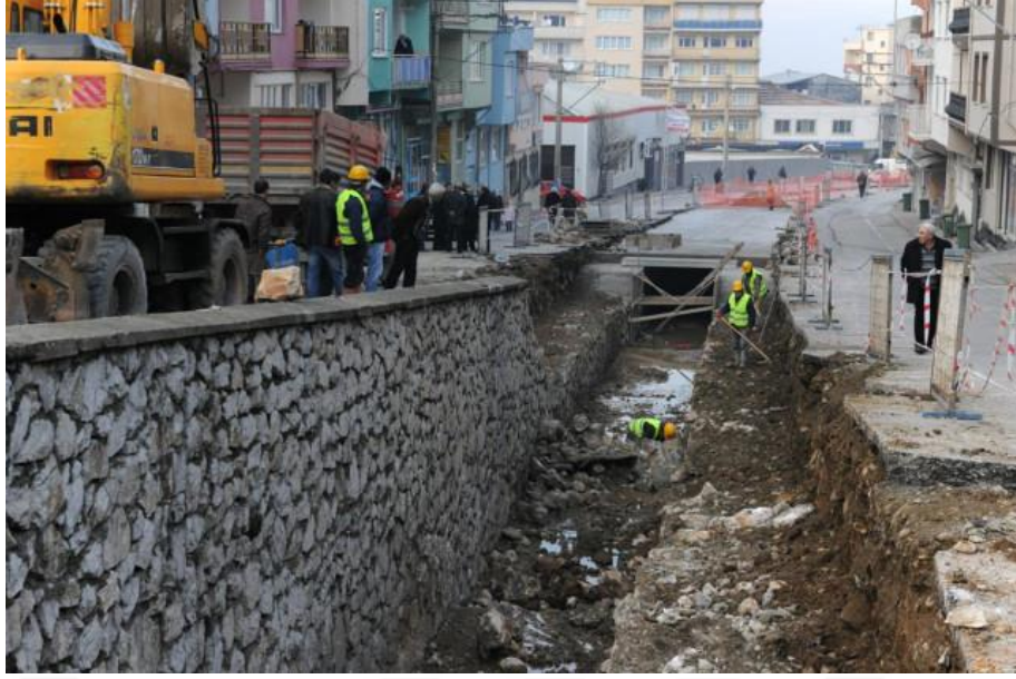
Şekil 3.34 : Dalyan Sokak'ın ortasından geçen Akçalar Deresi kapatma çalışmaları (Bursa'da Altyapı Yenileniyor, 2012).
