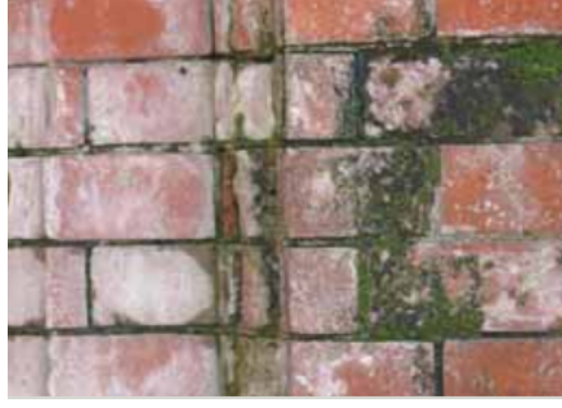
Şekil 2.37 : Tuğla duvar yüzeyinde çiçeklenme ve yosun büyümesi (Donnelly, 2009).
