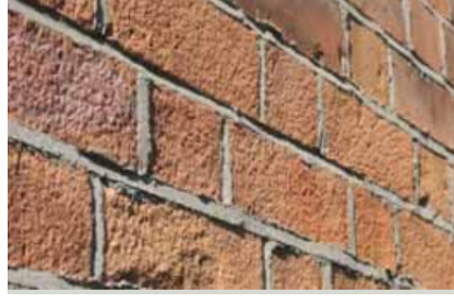
Şekil 4.5 : Uygun olmayan aşındırıcı temizlik ile koruyucu yüzeyini kaybetmiş ve bozulmaya karşı savunmasız hale gelmiş tuğla örneği (Donnelly, 2009).
