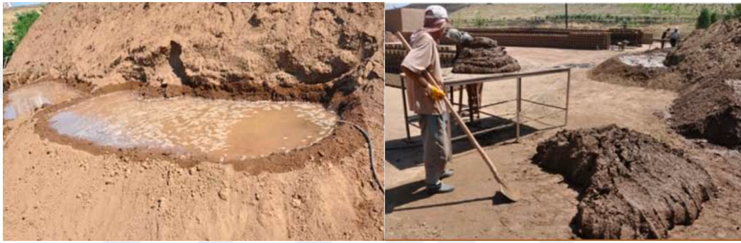
Şekil 2.4 : Ortası boşaltılıp su eklenmiş kil (solda), stabilize hale getirilmiş kil hamuru (sağda) (Dalkılıç ve Nabikoğlu, 2017).
