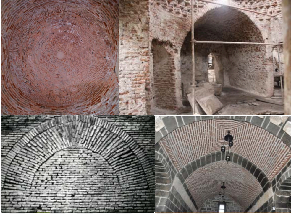
Şekil 2.2 : Sırası ile tuğla kubbe örneği (Sivas Gök Medrese) (Öter, 2021), tuğla duvar örneği (İzzet Paşa Hamamı) ((Naldan, 2019); tamamı tuğla ile inşa edilen İplikçi Camii'nin mihrap arkasındaki kemeri (Yasa, 2016), Tuğla beşik tonoz (Zinciriye Medresesi) (Dalkılıç ve Nabikoğlu, 2017).
