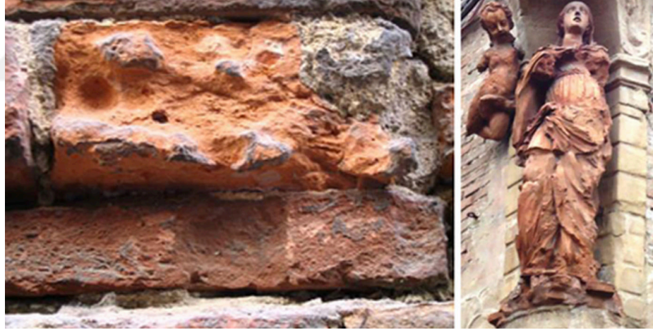
Şekil 2.36 : Casa Beccafumi'nin (XVI. Yüzyıl, Siena, İtalya) cephesindeki tuğlaların toz haline gelmesi (solda); Corpus Domini Manastırı'ndaki (XV Yüzyıl., Bologna, İtalya) dekoratif bir pişmiş toprak heykelin derin erozyonu (sağda) (Franzoni ve diğ, 2014).
