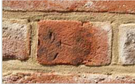
Şekil 4.8 : Tuğlaya uygulanmış harçla onarım çalışması. Gerektiğinde ve iyi işlikle yapıldığında geçici olarak istenilen etkiyi verdiği görülmektedir (Donnelly, 2009).
