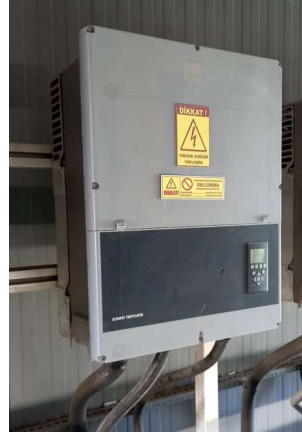
Şekil 3. 5. Gerçek zamanlı veri alınan GES invertör cihazı
