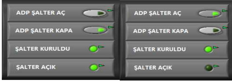
Şekil 4. 37. Uzaktan şalter kontrolünde, kontrol panelindeki butonların ve ledlerin çalışma görünümü
