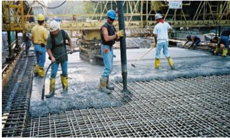
Şekil 2.21. FRP hasırların köprü döşemelerinde kullanımı (Durmaz, 2018)
