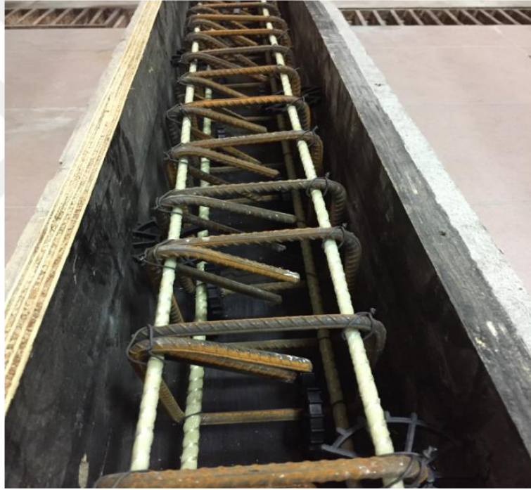
Şekil 2.19. FRP donatıların çelik donatılarla beraber kullanımı (Öztürk, 2018)
