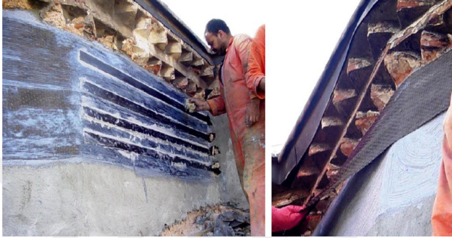
Şekil 2.29. FRP ile güçlendirilmiş kubbe kasnağı (Pehlivan, 2019)
