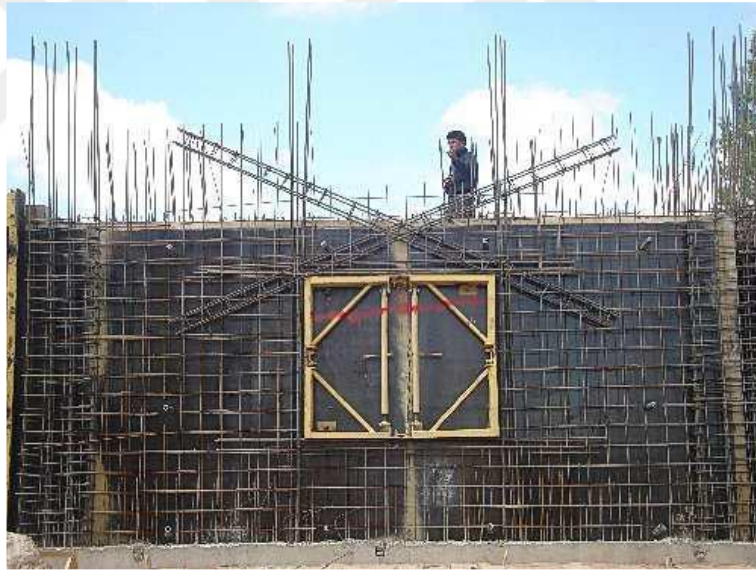
Şekil 3.14. Tünel kalıp sisteminde pencere boşluğunun bırakılması (Gençbay, 2017)
