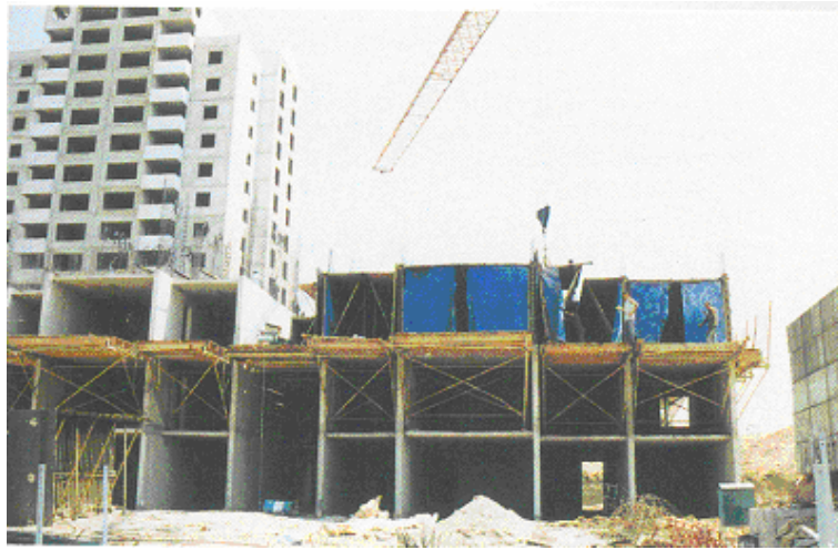
Şekil 3.9. Tünel kalıbın koruyucu perdelerle kapatılarak kürlemeye hazırlanması (Sucu, 2006)
