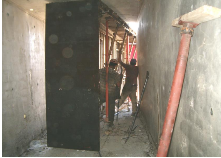
Şekil 3.18. Tünel kalıbın tekerlekleri üzerinde dışarıya çıkarılması (Sucu, 2006)
