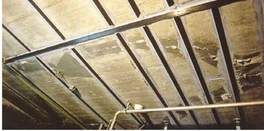
Şekil 2.24. Betonarme döşemede FRP şeritlerin çift yönlü olarak uygulanması (Yılmaz ve diğ., 2002)
