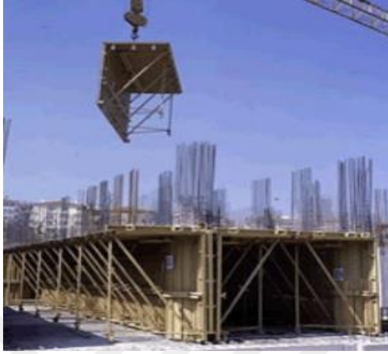
Şekil 3.13. Tünel kalıp elemanın yerine yerleştirilmesi (Kıncal, 2006)
