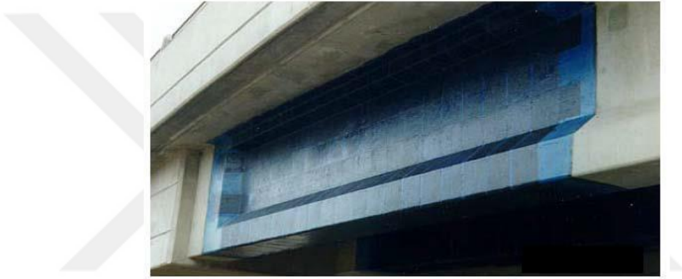
Şekil 2.10. CFRP kumaşlar kullanılarak köprü kirişinin güçlendirilmesi (Kadhim, 2020)
