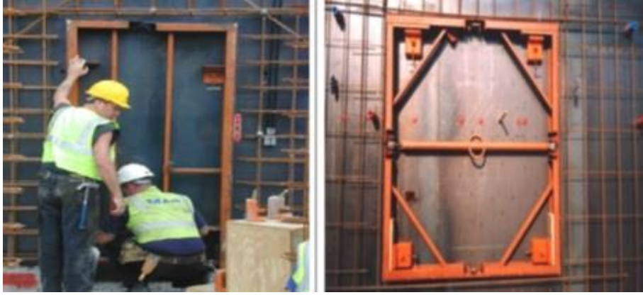
Şekil 3.6. Tünel kalıp imalatında kullanılan bazı ek parçalar (Kıncal, 2006)
