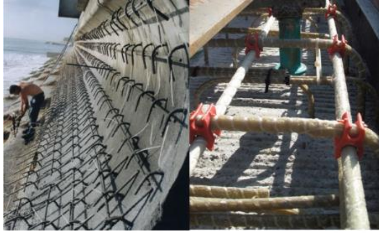
Şekil 2.20. FRP donatıların kıyı yapılarında kullanımı (Durmaz, 2018)
