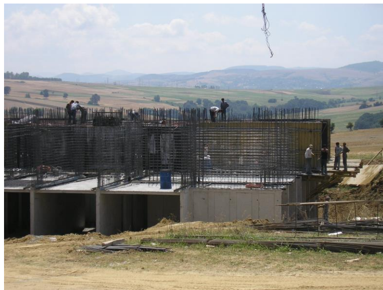
Şekil 3.11. Perde donatılarının yerleşimi (Sucu, 2006)
