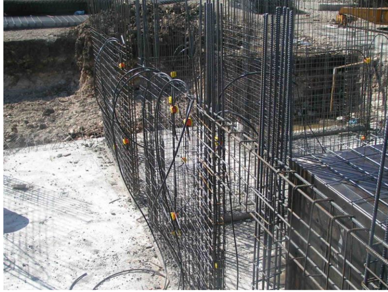
Şekil 3.12. Elektrik tesisatının donatılara bağlanması (Sucu, 2006)
