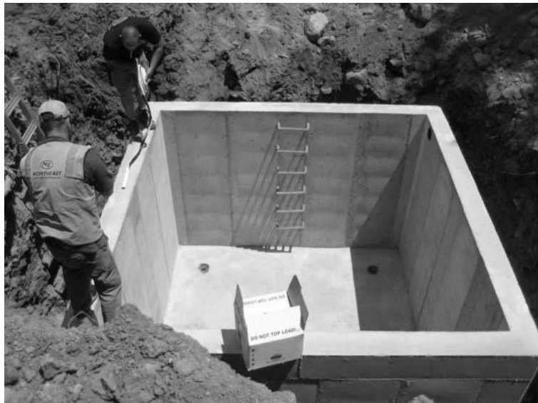
řekil 2.9. GFRP donatısı ile retilmiř betonarme altyapı elemanı rneėi
