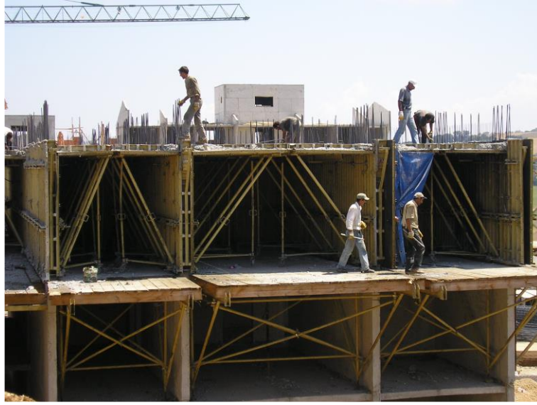
Şekil 3.8. Tünel kalıp destek elemanları (Gençbay, 2019)
