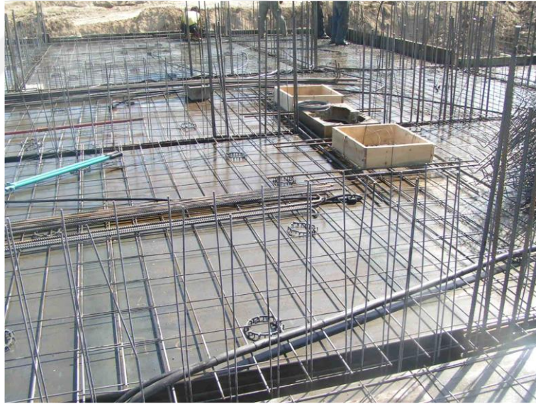
Şekil 3.16. Döşeme çelik hasırlarının yerleşimi (Sucu, 2006)
