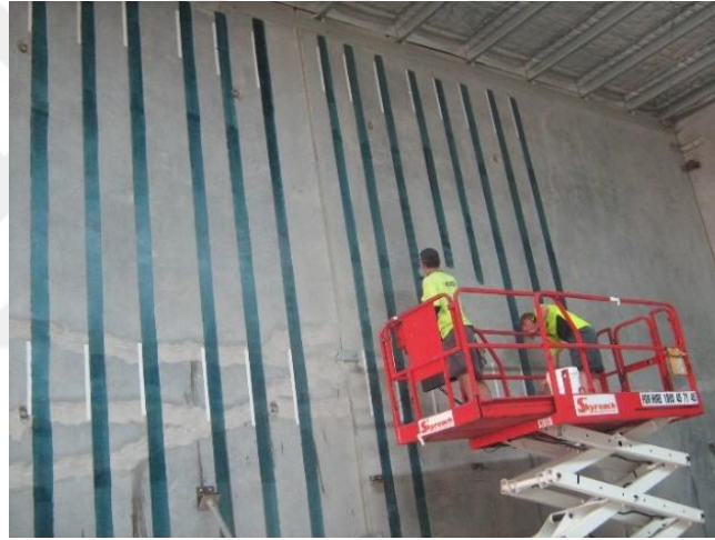
Şekil 3.20. Betonarme perdelerin FRP kompozit şeritler kullanılarak güçlendirilmesi (Remedial, 2022)
