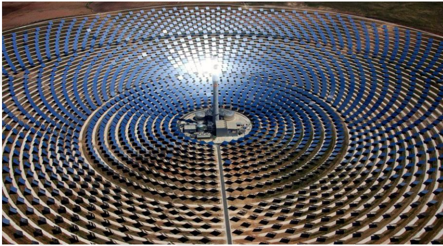
Şekil 1.9: Güneş Enerjisi Kulesi
