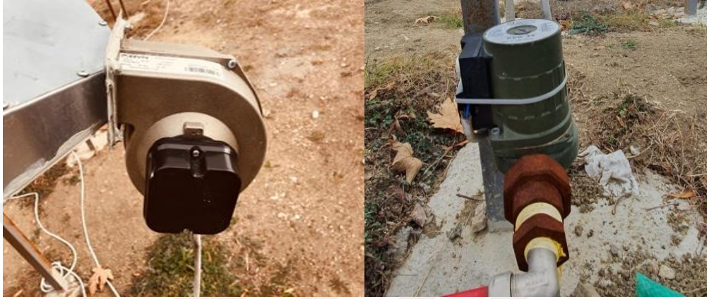
Şekil 3.7: Deney Sisteminde Kullanılan Sirkülasyon Pompası ve Fan
