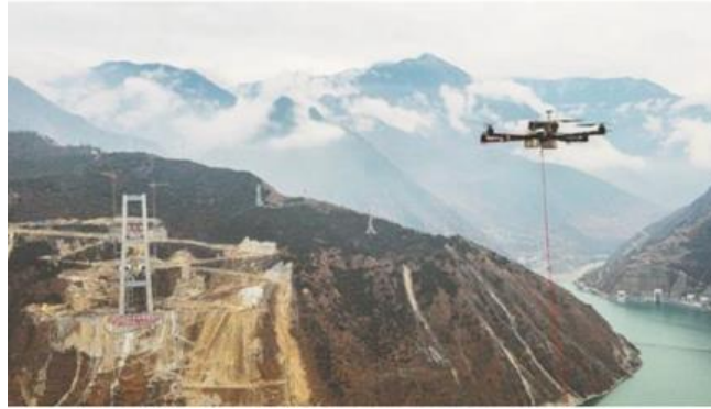
Şekil 2.3. Kuleler arasında ilk pilot hattı taşıyan İHA (http-5)
