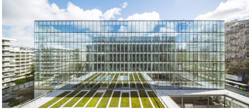
Şekil 2.38. Boulogne-Billancourt, Fransa’da Yer Alan Avenue Leclerc Ofis Binasının Ön Cephesi
