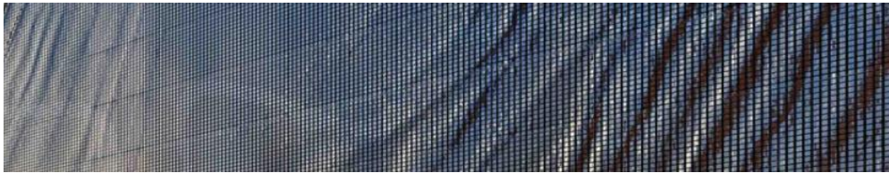
Şekil 2.13. Avustralya'daki Brisbane Havalimanı'nın İç Hatlar Terminali Otoparkının Dış Cephesinde Yer Alan Kinetik Membran
