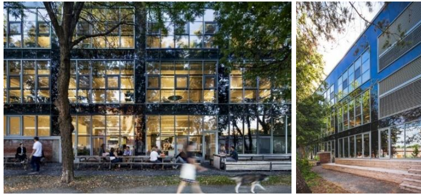
Şekil 4.92. ve Şekil 4.93. The Phenix Binasındaki Ortak Çalışma Alanları ve Atölyeler
