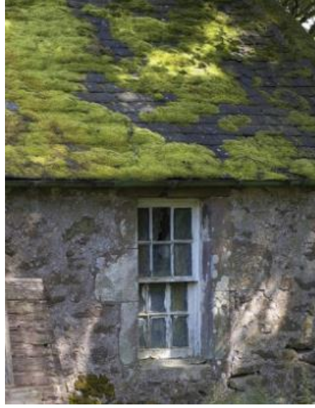
Şekil 2.9. İskoçya'daki Pentland Tepeleri Bölgesel Parkı'nda Yer Alan Tarihî Bir Evin Çatısı ile Duvarı
