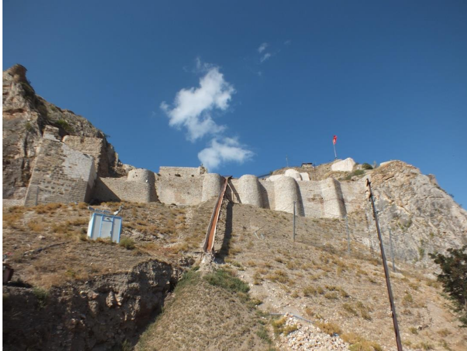
Şekil 4.122. Tokat Kalesi'nin yakın zamanda onarım gören dış surları (Fotoğraf: Müslüm Aydın)
