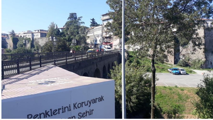
Şekil 4.94. Trabzon Tabakhane Köprüsü'nün günümüzdeki görünümü (Fotoğraf: Müslüm Aydın)
