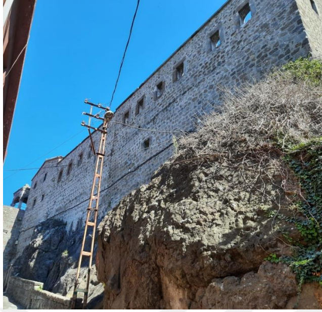
Şekil 4.74. Trabzon Kızlar Manastırı'nın kale görünümü (Fotoğraf: Müslüm Aydın)
