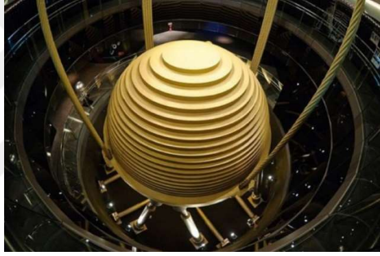
Şekil 2.10 Taipei 101’de kullanılan AKD
