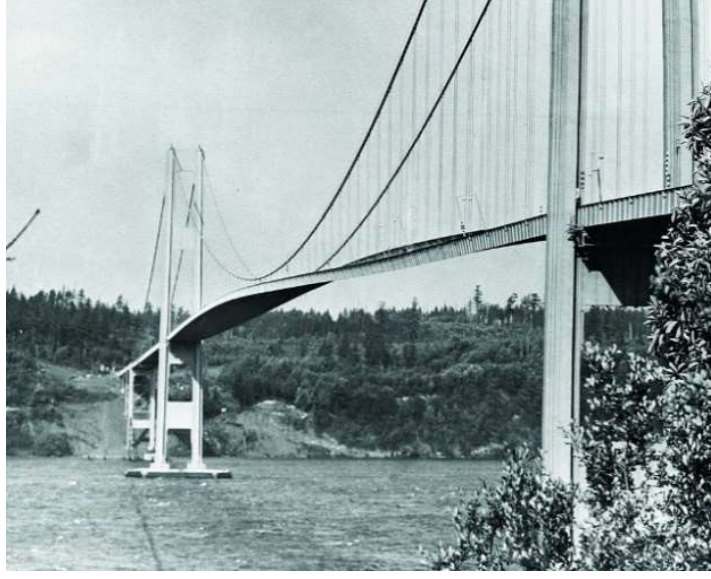
Şekil 2.3 Salınım hareketi yapan Tacoma köprüsü
