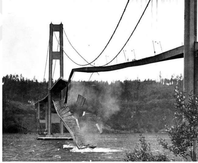
Şekil 2.4 Rezonans etkisiyle çöken Tacoma köprüsü
