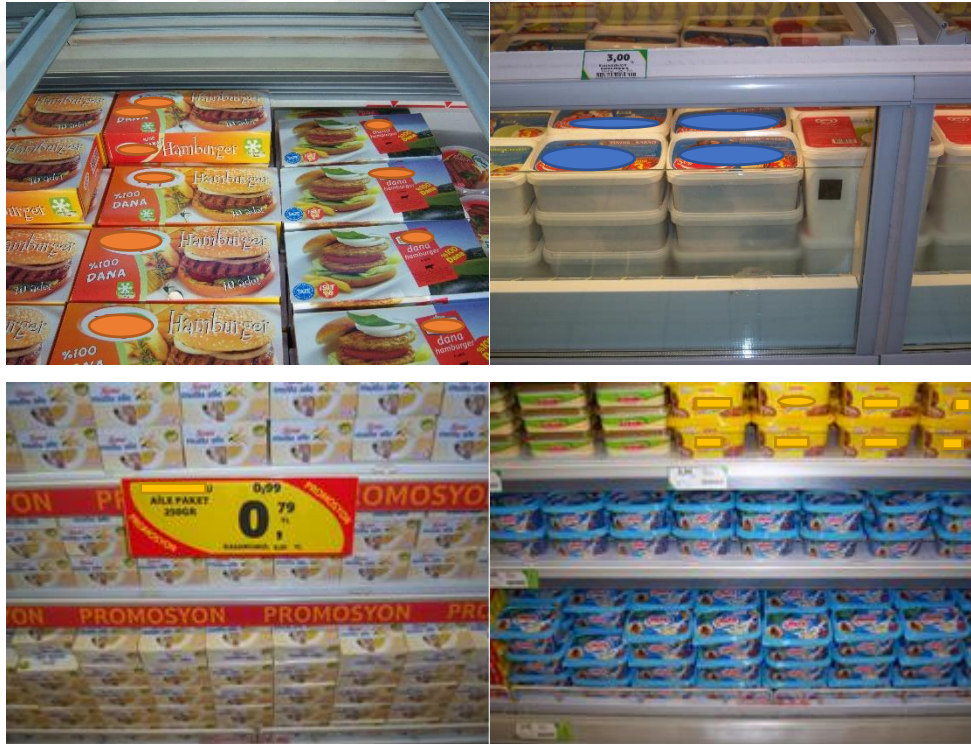
Şekil 26. Hava ızgarası önüne yapılan yanlış dolum şekli
