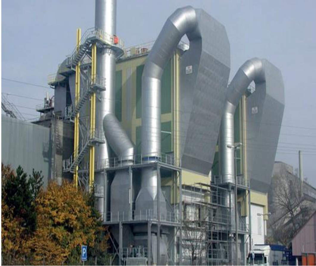
Şekil 2.12: Elektrik alanı oluşturarak panellerde toz toplama ve üretime geri kazandırma sistemi
