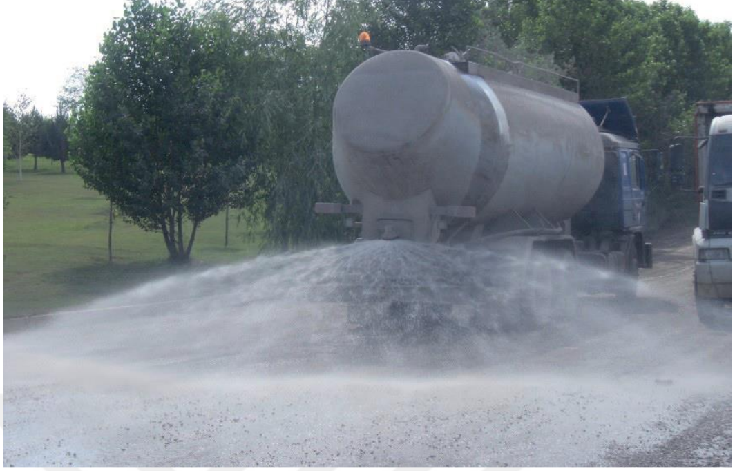
Şekil 2.11: Nakliye yollarında rüzgar ve trafik sebebi ile tozun havaya karışmasını engelleyen su püskürtme sistemi
