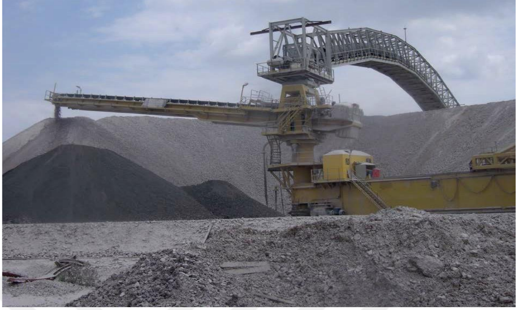
Şekil 2.10: Malzeme yığın işleminde rüzgârla tozun havaya kırılmasını engelleyen su püskürtme sistemi
