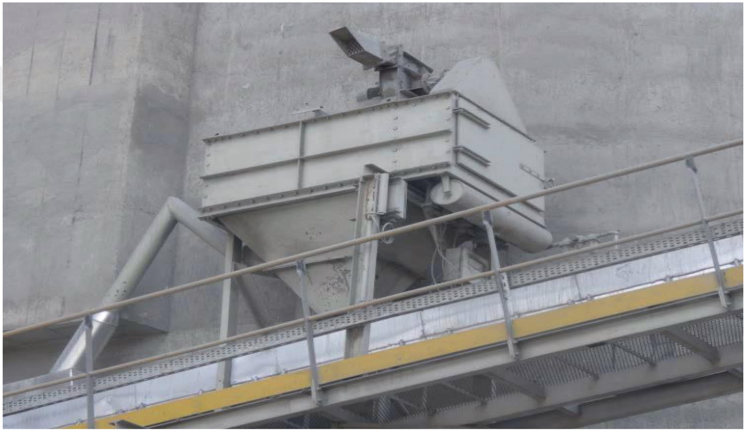
Şekil 2.13: Toz tutucu kasede sahip ve tutulan tozu üretime geri boşaltma özelliği olan filtreler
