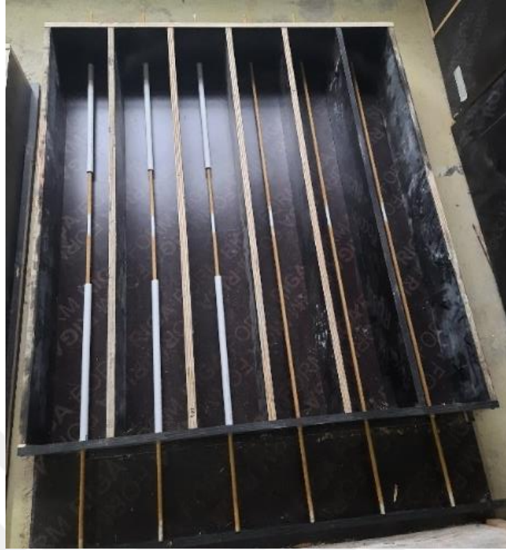
Şekil 5.36 : Kiriş kalıplarının hazırlanması.
