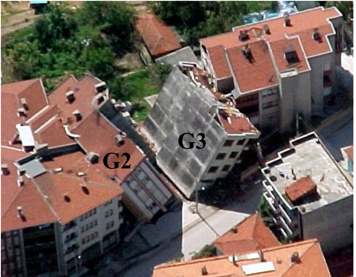
Şekil 4.33: Adapazarı'ndaki bitişik nizam olarak inşa edilmiş yapıların, sıvılaşma nedeniyle aldığı hasara bir örnek (apps.peer.berkeley.edu, Erişim tarihi: 15 Temmuz 2022).
