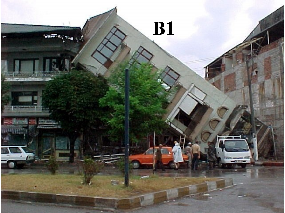
Şekil 4.37: Adapazarı'ndaki bitişik nizam yapılarda uçlarda kalan yapıların, sıvılaşma nedeniyle aldığı hasara bir örnek (apps.peer.berkeley.edu, Erişim tarihi: 15 Temmuz 2022).
