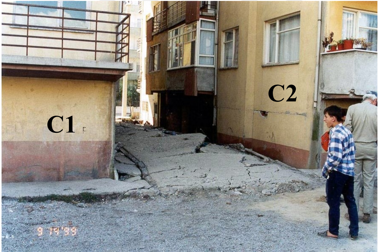
Şekil 4.35: Adapazarı'ndaki boşluklu bina sıralarında, sınılaşma sonucu binalar arasında oluşan kabarmaya bir örnek (apps.peer.berkeley.edu, Erişim tarihi: 15 Temmuz 2022).
