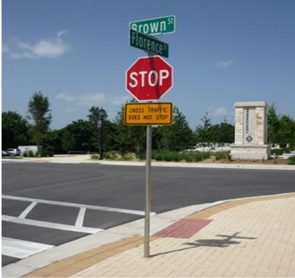
Şekil.2.22. Kaldırımlarda bulunan levhaların kafaya çarpmayacak yükseklikte yerleştirilmesi (Txcorr, 2021)
