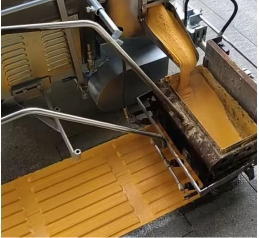
Şekil 2.37. Mevcut alanda hissedilebilir yüzey için hazırlayan makine
