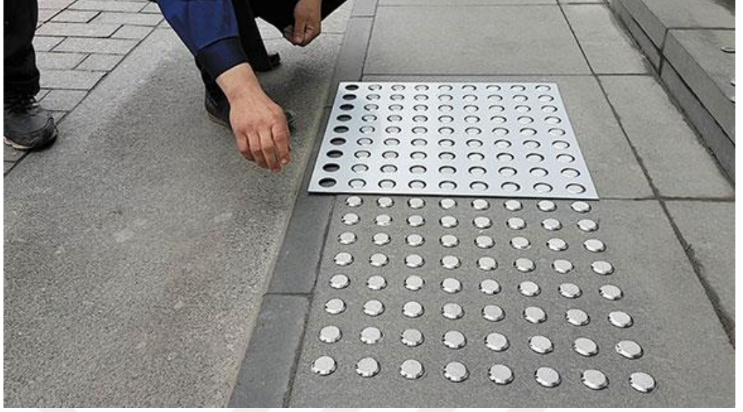
Şekil 2.33. Metal görme engelli hissedilebilir yüzey malzemesi (Tiflocentre,2022)
