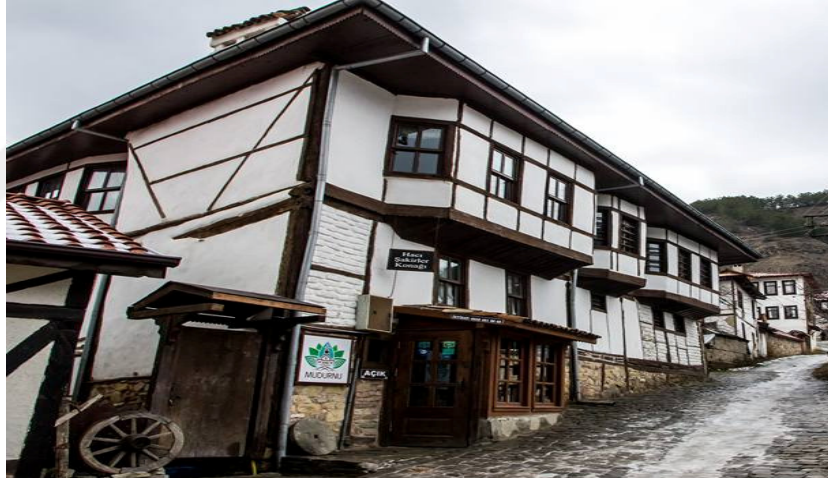
Resim 7: Mudurnu Hacı Şakirler Konağı
