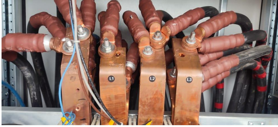
Şekil 4.28. Yanlış bara bağlantısı
