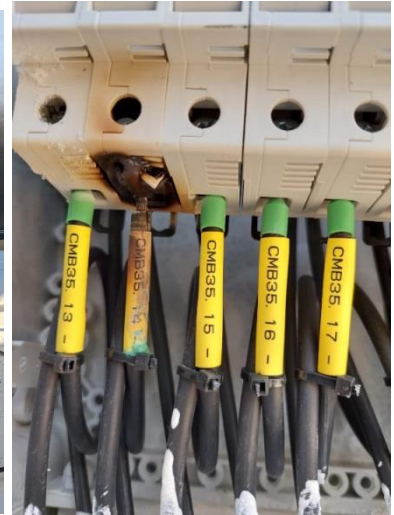
Şekil 4.11. Kablolama hatası sonucu oluşan yanmalar
