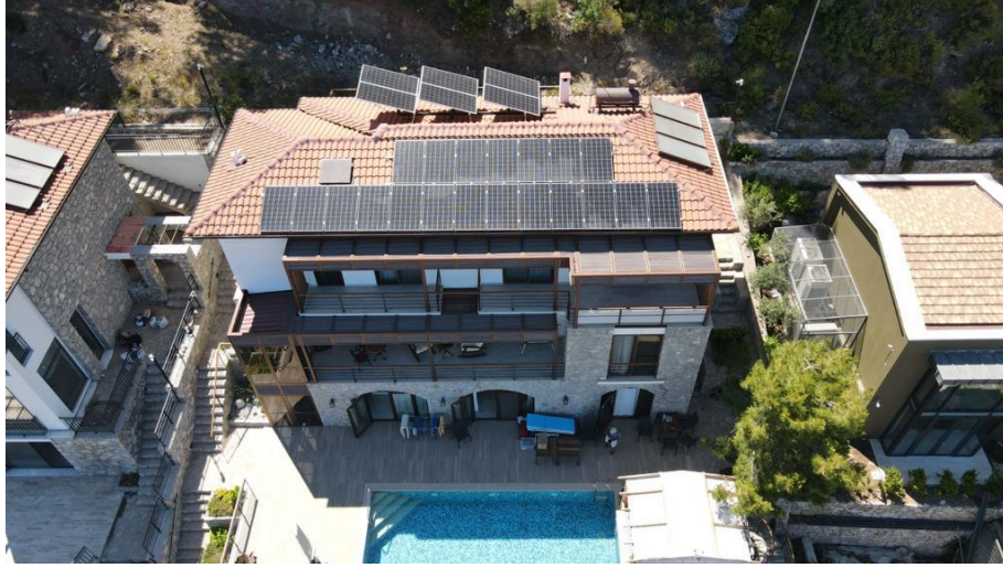
Şekil 4.8. Gölgelemenin olmaması için parçalı yerleşim
