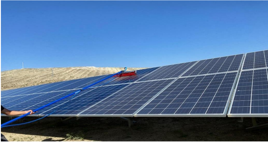
Şekil 4.6. Tozlanmanın manuel yıkama ile temizlenmesi
