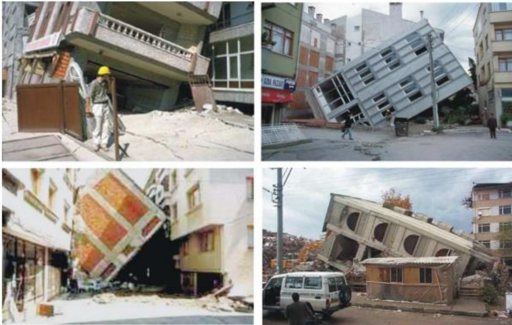
Şekil 2.2. 17 Ağustos depreminde Adapazarı’nda gözlemlenen sıvılaşma kaynaklı hasarlar (Selçuk, 2009)
