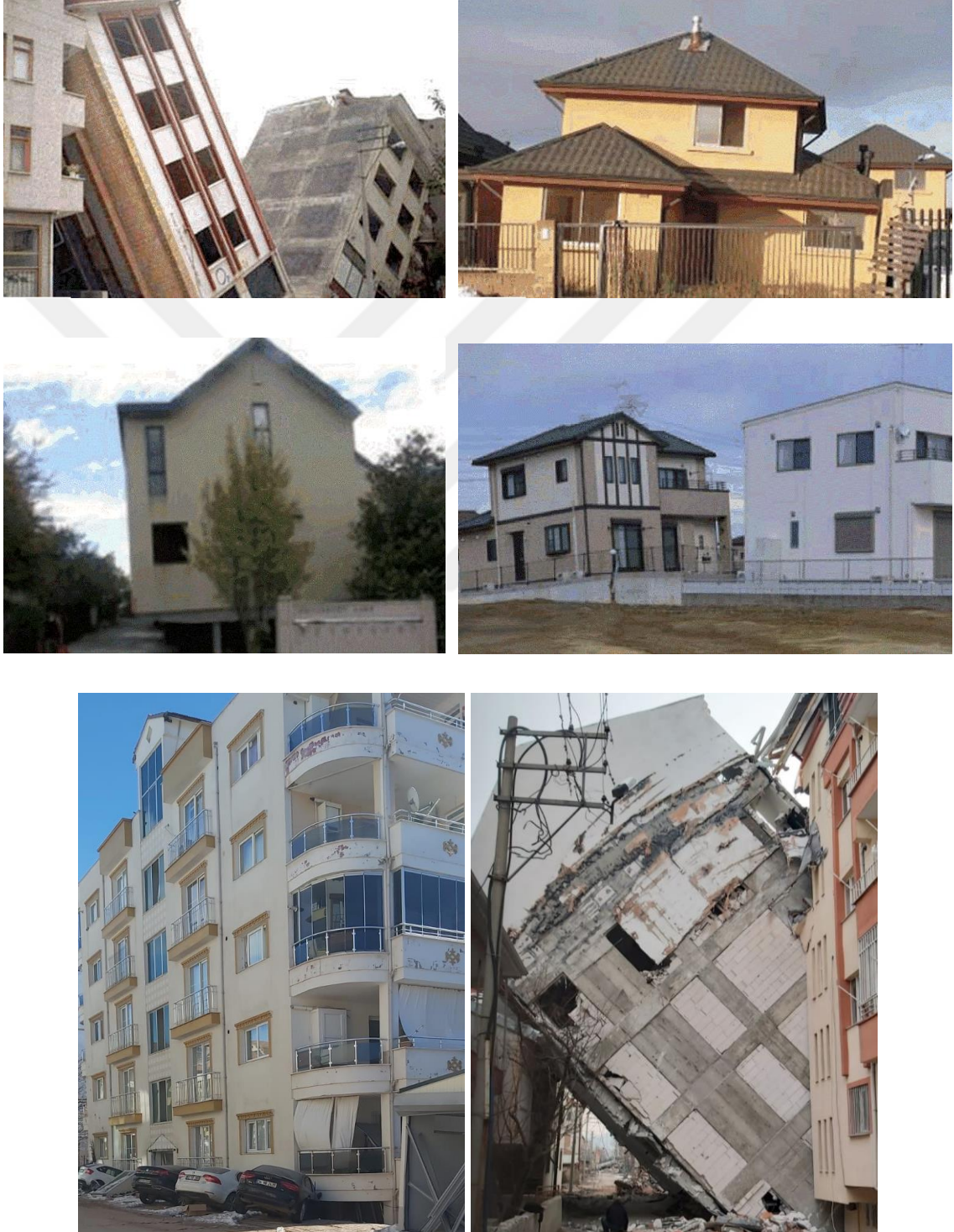
Şekil 1.1. Kocaeli-Türkiye (1999), Maule-Şili (2010), Tohoku-Japonya (2011), Christchurch-Yeni Zelanda (2011) ve Kahramanmaraş-Türkiye (2023) depremlerinde görülen tipik sıvılaşma kaynaklı bina hasarları
