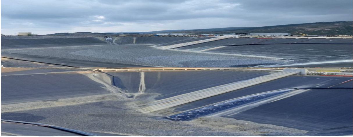
Şekil 5.4. Yüklü Havuz Kuş Topları Görünümü
