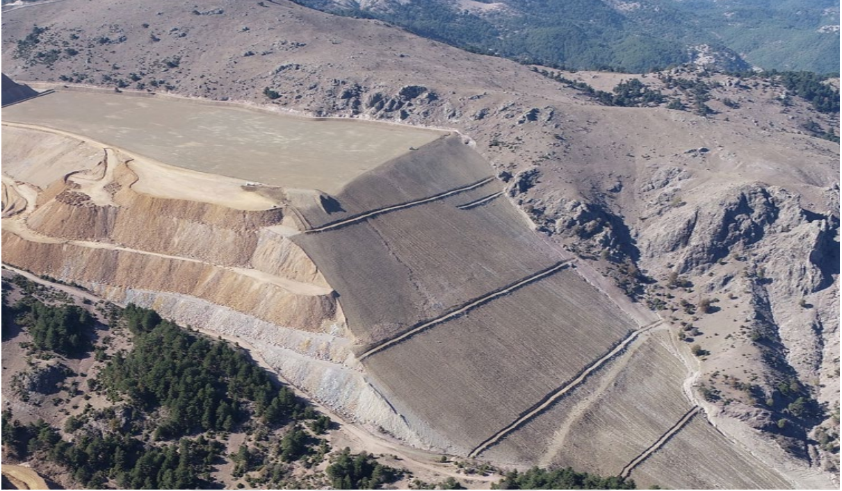
Şekil 5.11. Pasa Sahası Teraslama Çalışması
