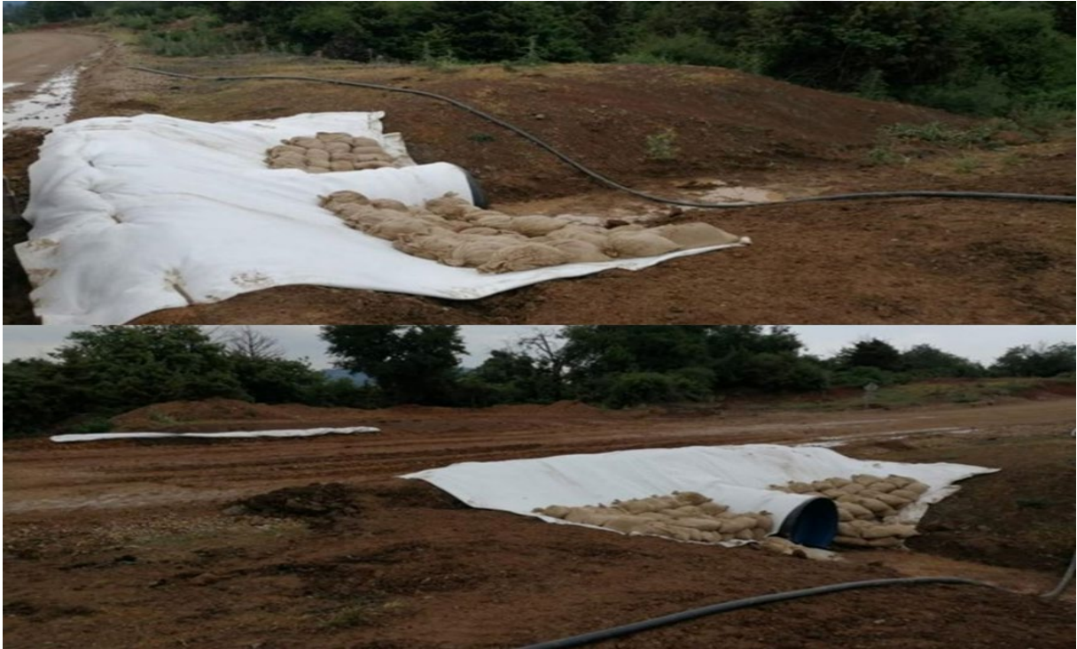
Şekil 5.1. Maden Sahası Kaplumbağa Geçidi Görünümü
