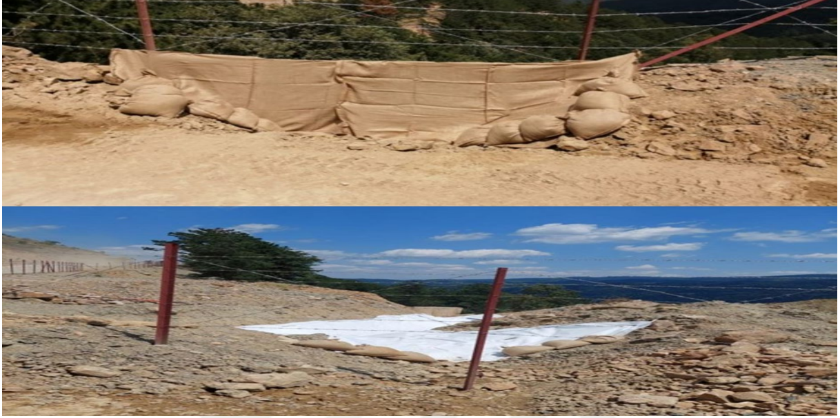
Şekil 5.13. Maden Sahası Silt Fence Çalışması
