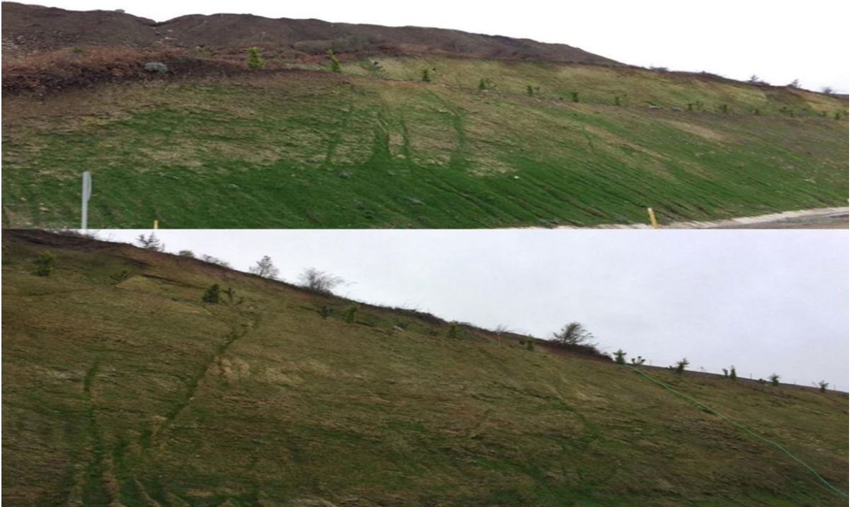
Şekil 5.8. Hydroseeding Sonrası Çimlenme Görünümü
