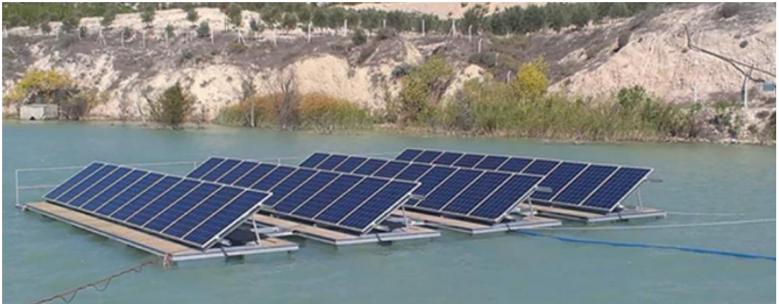
Şekil 2.8. Yüzer güneş santrali Azmak 2 Hidroelektrik Santrali ( tr.tyt.com.tr ).
