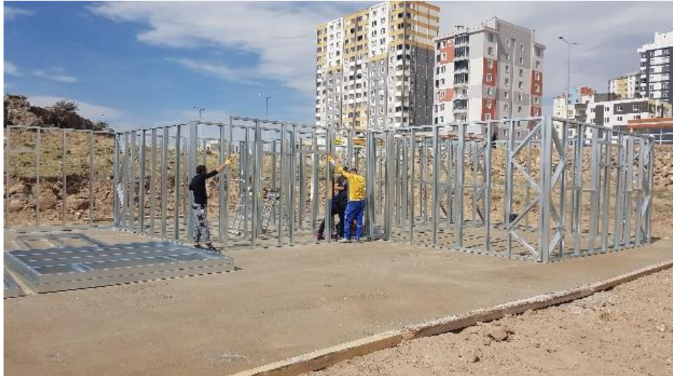
řekil 3.39. İlk Kurulan Hafif elik Duvar Panelleri - 1
