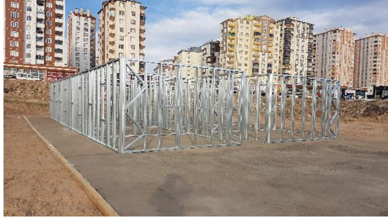
Şekil 3.41. Montajı Tamamlanmış Hafif Çelik Duvar Panelleri
