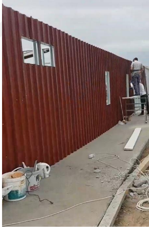
Şekil 3.47. Kurduvar Kaplama
