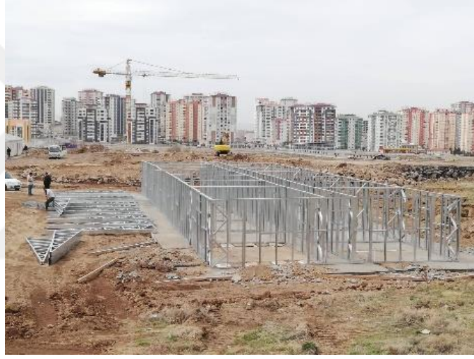
Şekil 3.42. Hafif Çelik Çatı Makaslarının Hazırlanması
