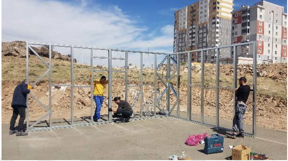
řekil 3.39. İlk Kurulan Hafif elik Duvar Panelleri - 1
