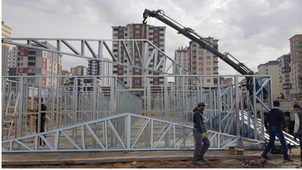
Şekil 1.16. Panel Sistemli Hafif Çelik Yapı Kurulumu
