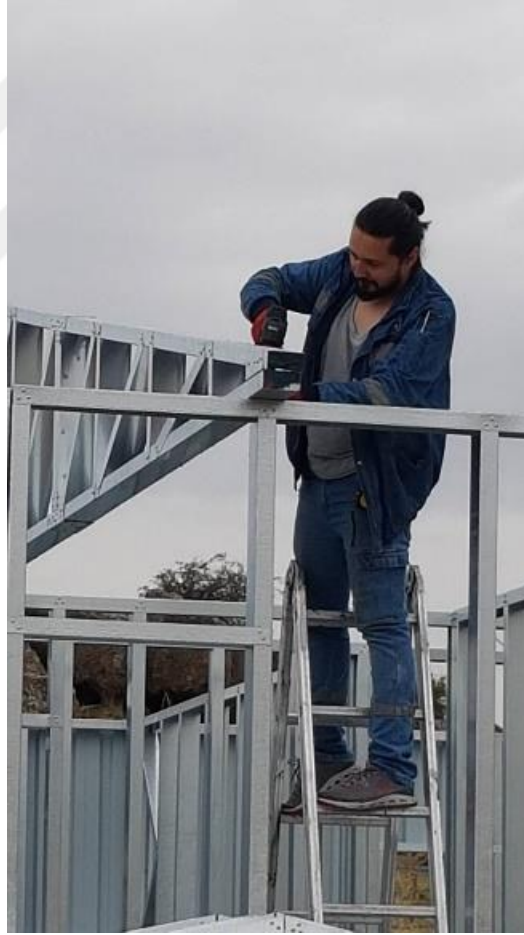
Şekil 3.45. Hafif Çelik Çatı Makas Montajı – 3
