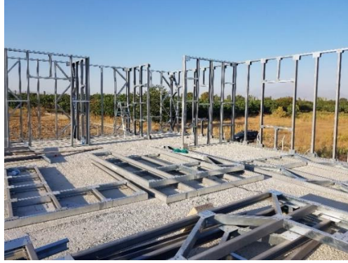
Şekil 1.12. Hafif Çelik Yapı Karkas Kurulumu
