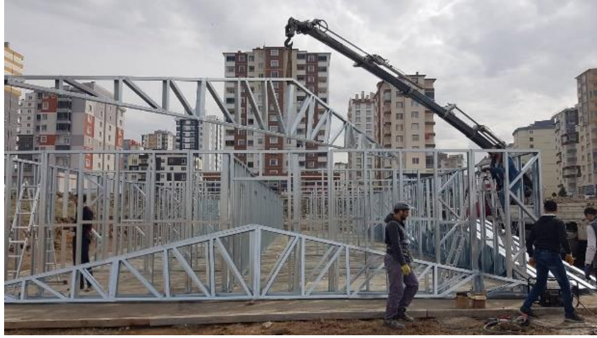
Şekil 3.44. Hafif Çelik Çatı Makas Montajı - 2
