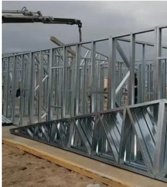
Şekil 3.43. Hafif Çelik Çatı Makas Montajı - 1
