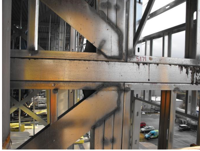
Şekil 1.15. Hafif Çelik Yapı Kaynaklı Bağlantı Örneği
