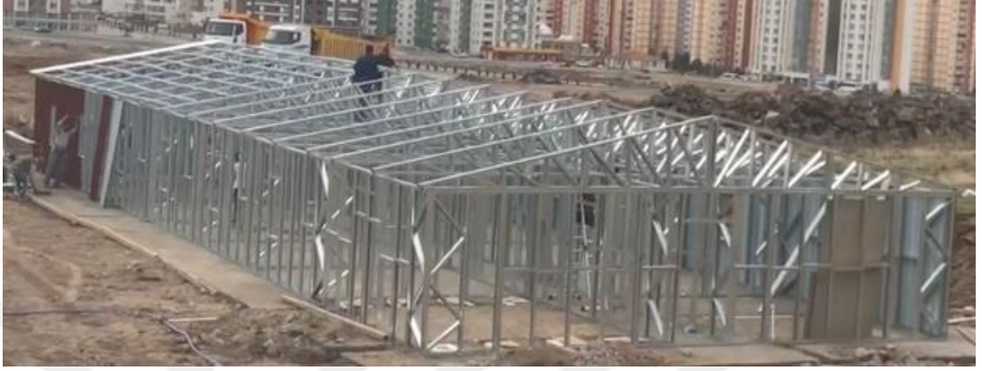
Şekil 3.46. Çatı ve Kurduvar Kaplamalarının Kaplama - 1
