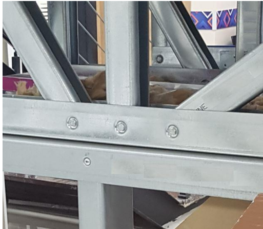
Şekil 1.14. Hafif Çelik Yapı Vidalı Bağlantı Örneği
