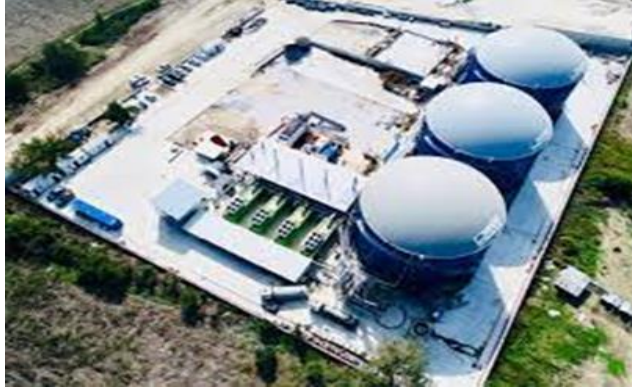
Şekil 4.13 İzmir halilbeyli biyogaz tesisi
