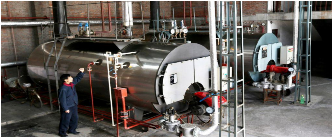
Şekil 2.7 : Isı üretmek için kullanılan bir biyogaz yakıcı (Badem, 2017).
