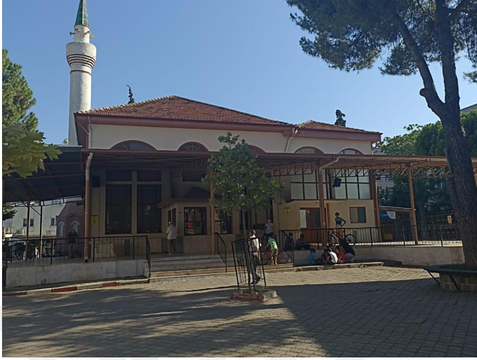
Şekil 22. Turgutlu Dereköy Camii betonarme ilave kısmı
