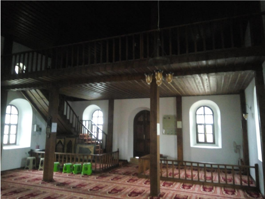
Şekil 24. Düz mahfil tipi örneği: Bulancak Ahmetli Camii (Kişisel arşiv, 2017)
