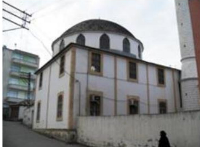
Şekil 43. Restorasyon öncesi caminin durumu (Çalık, 2017)
