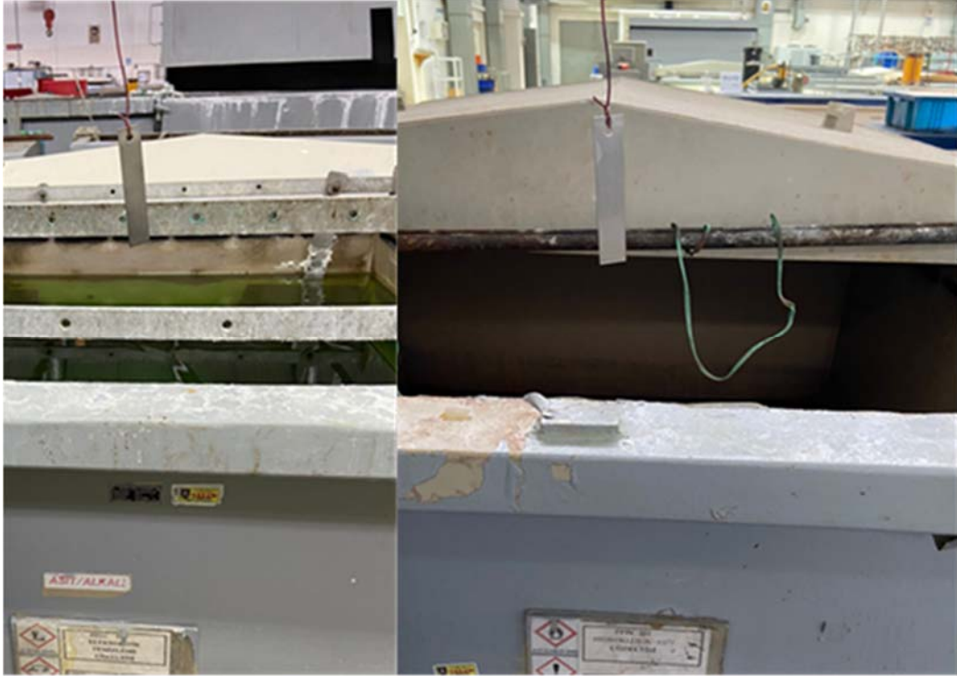
Şekil 3.5. Elektrolitik Temizleme(Sol), Hidroklorik Asit ile Temizleme (Sağ)
