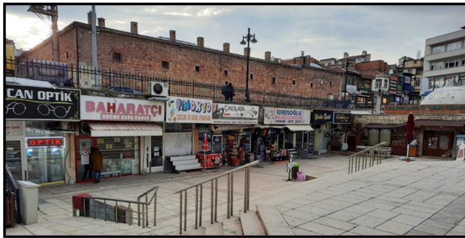
Şekil 4.25 Nasrullah Meydanında bulunan tarihi ticaret yapıları
