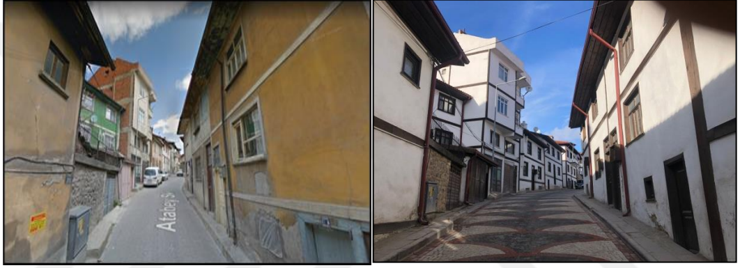
Şekil 4.12 Atabey Sokak Sağıklaştırma Çalışmaları öncesi ve sonrası görünümü
