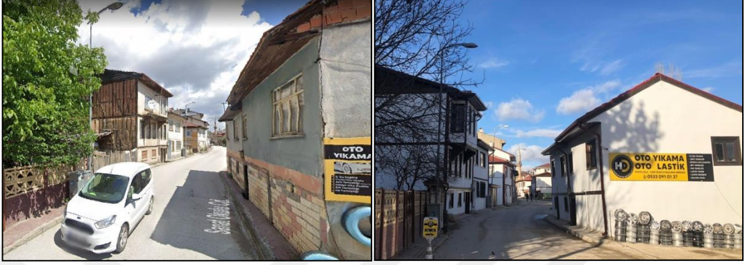
Şekil 4.18 Sanat Okulu Caddesi Sokak Sağlıklaştırma Projesi öncesi ve sonrası sokak görünümü
