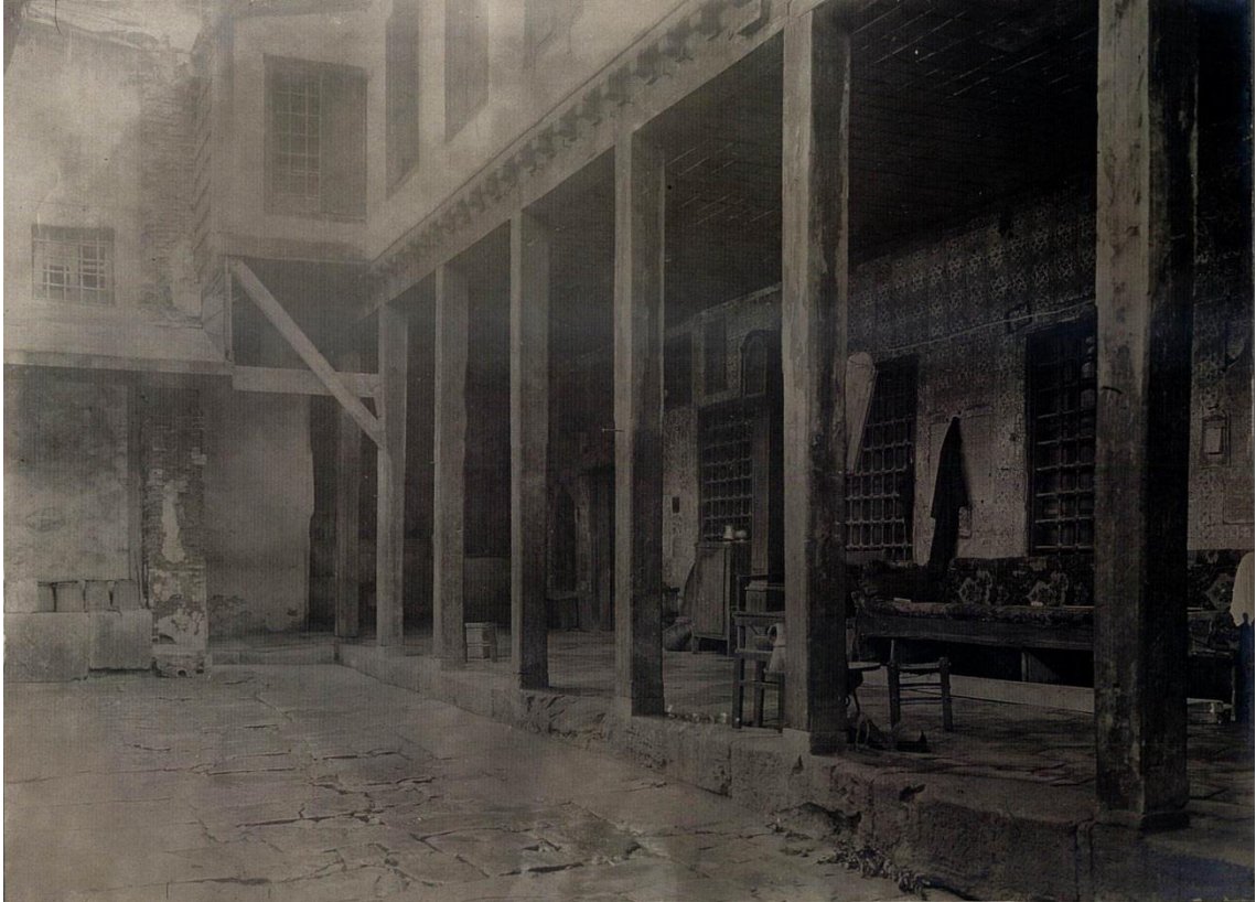
Şekil 3.89 Zülüflü Baltacılar Koğuşu taşlığa bakan cephe ve revak kısmı, 1920'li yıllar (İRAM arşivi)
