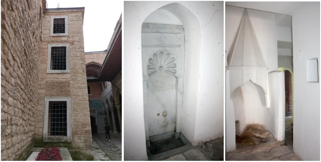
Şekil 3.70 Cüceler Koğuşu avluya bakan dar cephesi ve zemin kat iç mekânı (B. Beşinci)
