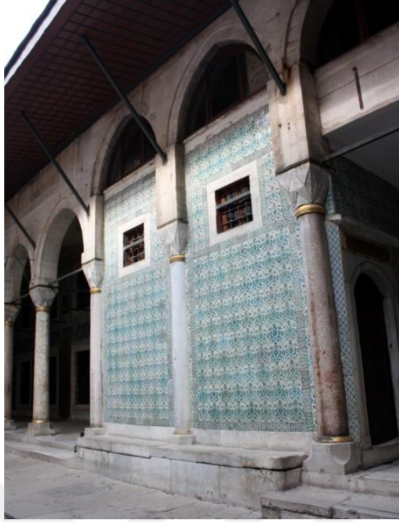
Şekil 3.50 Revak kısmında sonradan kapatıldığı bilinen Pabuçluk (Ortanca Hapishanesi) (İRAM arşivi)
