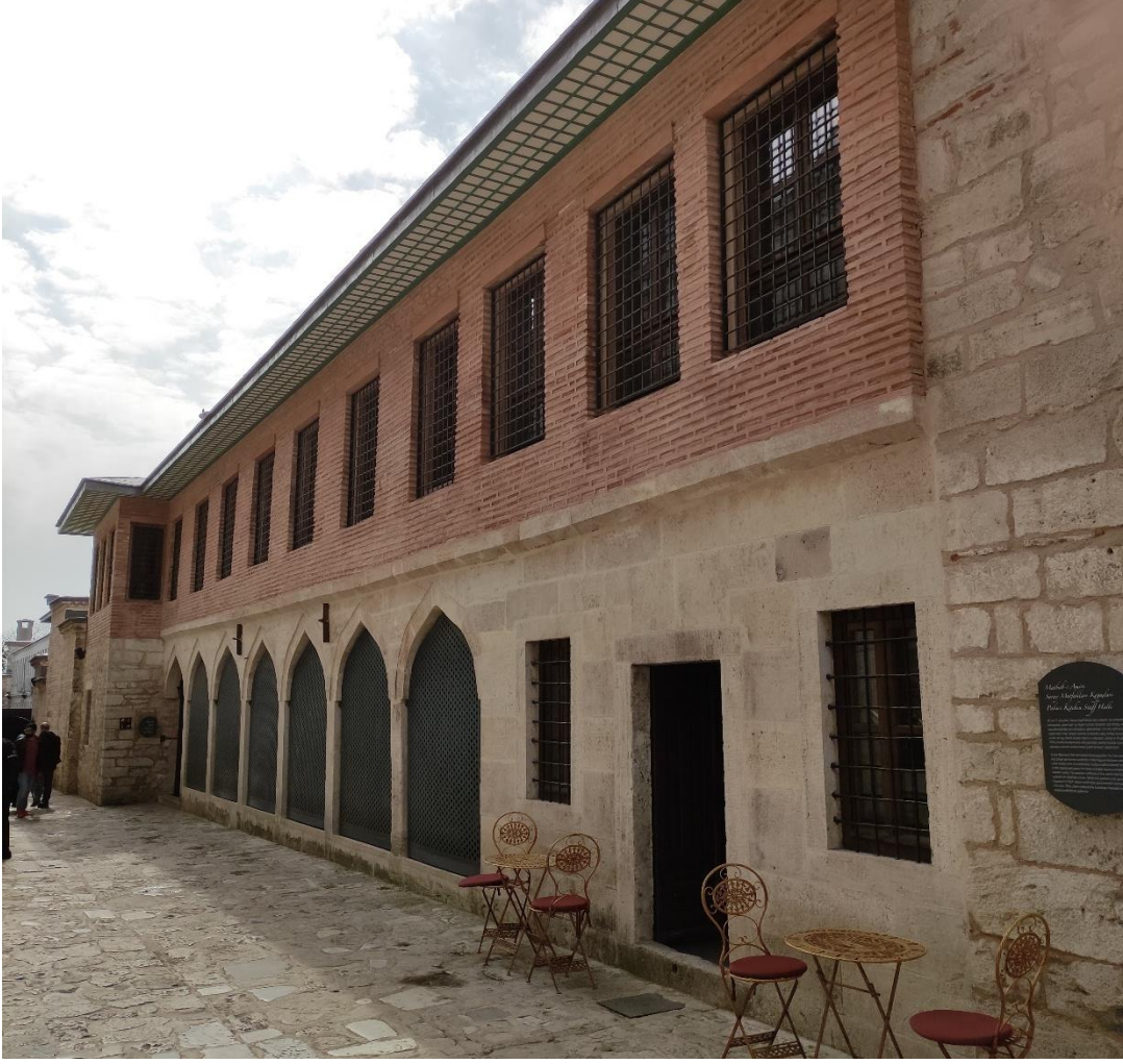
Şekil 3.107 Has Mutfak Kapısı solunda bulunan koğuş cephesinin günümüzdeki hali (B.Beşinci)
