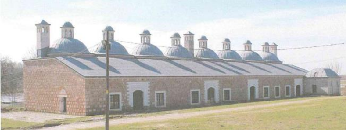
Şekil 2.10 Edirne Sarayı Mutfakları onarım sonrası, 2018 (İRAM arşivi)
