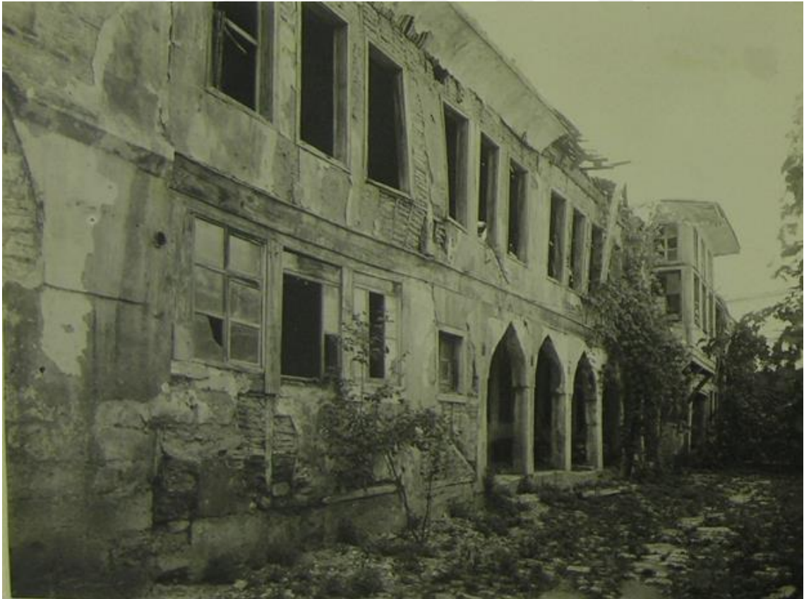
Şekil 3.103 1938-1944 yılları onarım öncesi Mutfaklar Koğuşları'nın durumu (İRAM arşivi)
