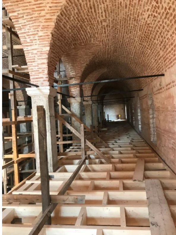
Şekil 3.20 2017 yılında Seferli Koğuşu restorasyon çalışmaları şirvan kısmı (Günberk İnş.)
