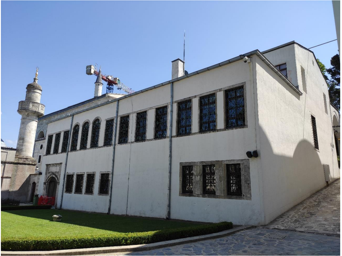
Şekil 3.24 Günümüzde idari bina olarak kullanılan Kiler Koğuşu'nun IV. Avlu'ya bakan cephesi, 2022 (B.Beşinci)
