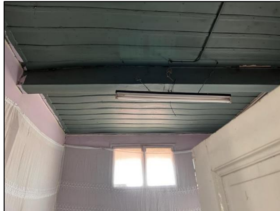
Şekil 34. 106 Mekanındaki Tavan Döşeme Kaplaması Kaynak: Ömerođlu, 2022
