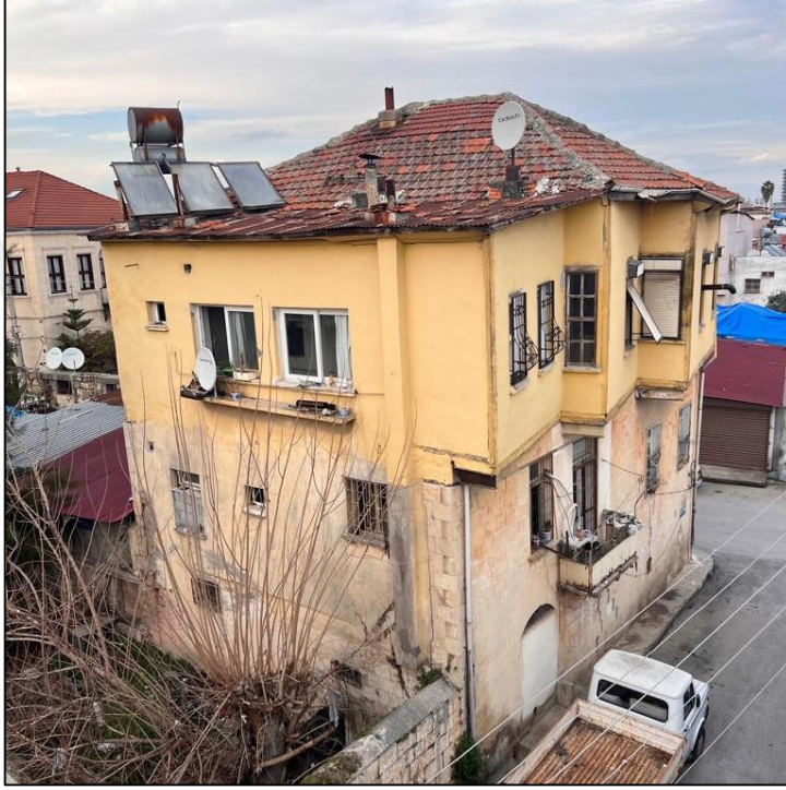
Şekil 26. 897 Ada, 11 Parselde Bulunan Geleneksel Evin Arka (Güneybatı) Cephe Görüntüsü
