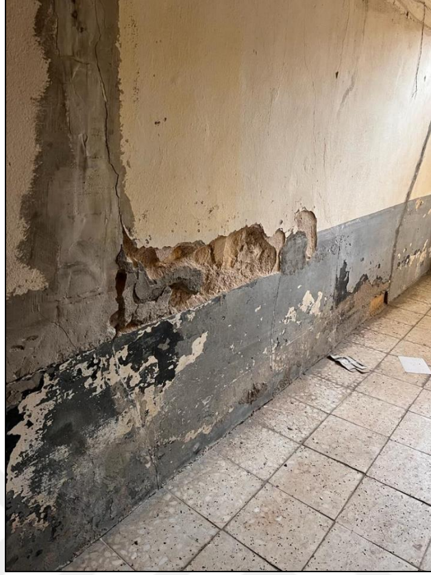
Şekil 28. Taşlık(Z02) Bölümündeki Duvarlar Kaynak: Ömeroğlu, 2022
