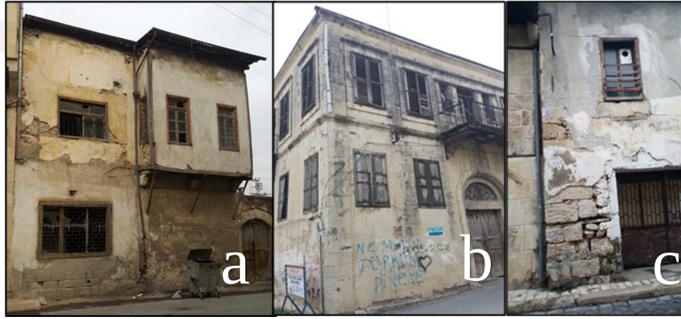
Şekil 17. Tarsus Şehit Kerim ve Kızılmurat Mahallelerinde Bulunan Geleneksel Evlerde Uzun Süreli Doğal Etkiler Sonucu Cephede Görülen Bozulma Örnekleri Kaynak: Ömeroğlu, 2021
