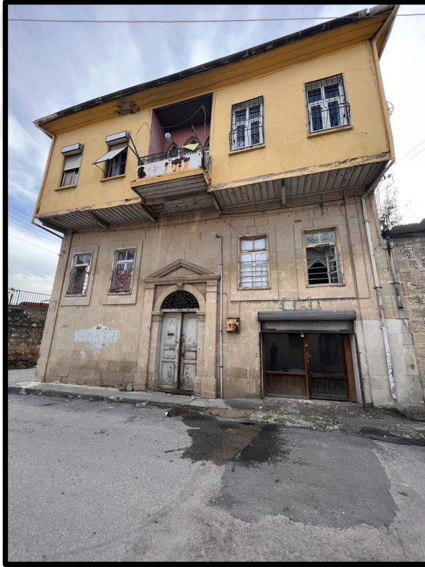
Şekil 21. 897 Ada, 11 Parselde Bulunan Geleneksel Evin Ön Cephe Görüntüsü Kaynak: Ömeroğlu, 2022
