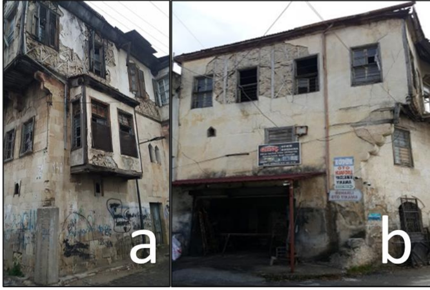
Şekil 19. Tarsus Şehit Kerim ve Kızılmurat Mahallelerinde Bulunan Geleneksel Evlerde İnsanların Neden Olduğu Bozulmalar Kaynak: Ömeroğlu, 2021
