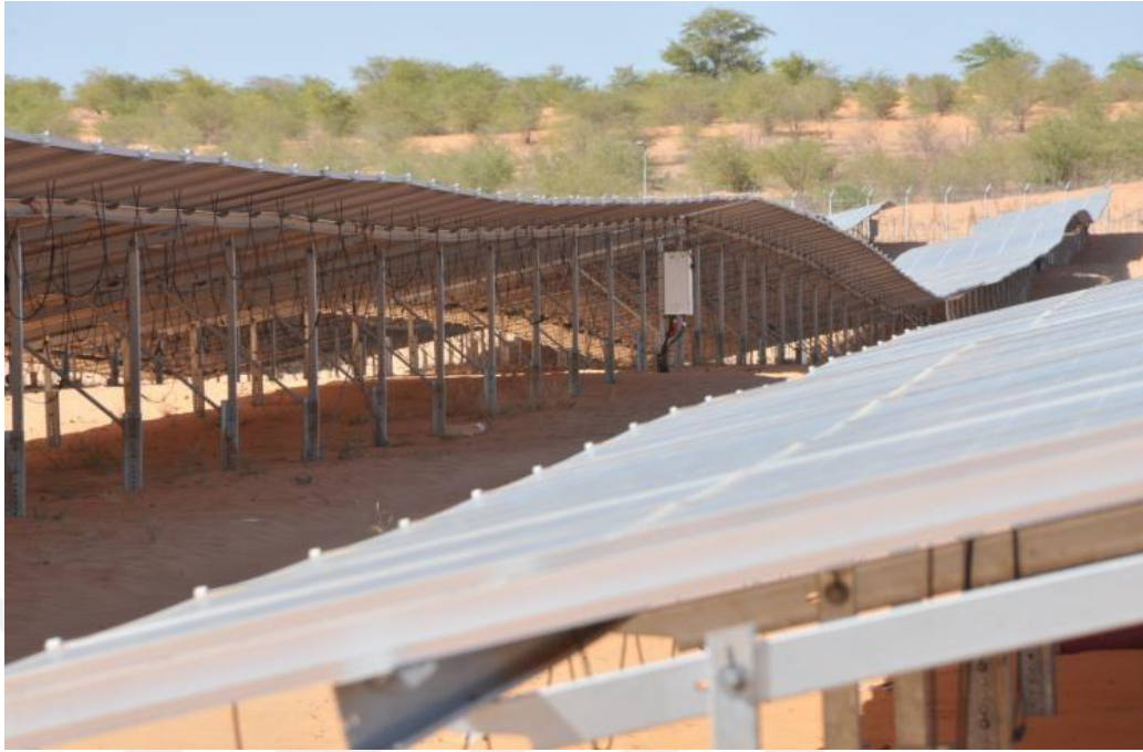
Şekil 2.3: 50 MW Güneş Enerjisi Santrali Montajı
