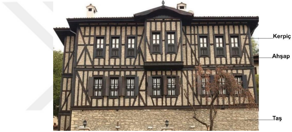
Şekil 2.10 Anadolu Türk Evinde Kullanılan Malzemelerin Yapı Üstünde Gösterimi (URL 3).
