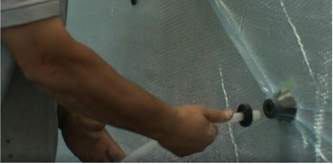
Şekil 1.30: Epoksi emiş hortumunun emiş supabına tam sızdırmazlık sağlaması için çift taraflı bant uygulaması.
