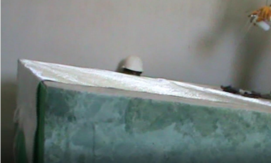
Şekil 1.15: Bloğun cam elyaf file ile kaplanması.
