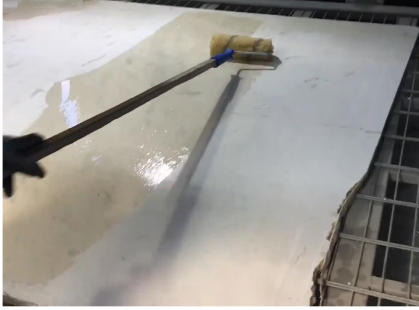
Şekil 1.40: Rulo ile ikinci kat epoksileme yapılma işlemi.
