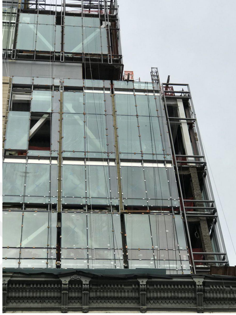
Şekil 4.69 : Çubuk sistemde sahada yapılan cam montaj işlemi (Url-23, 2022).
