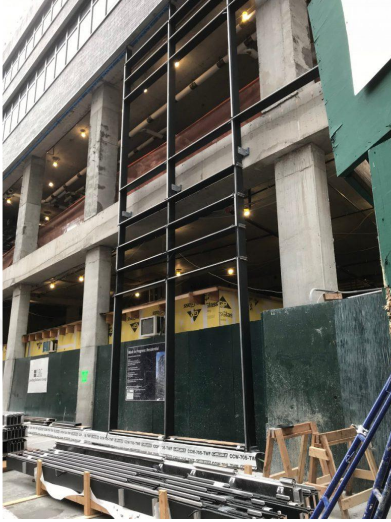
Şekil 4.68 : Çubuk sistem montaj aşaması (Url-22, 2022).
