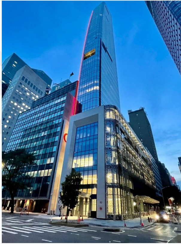
Şekil 2.3 : Türkevi Merkezi Binası, New York (Url-2, 2022).
