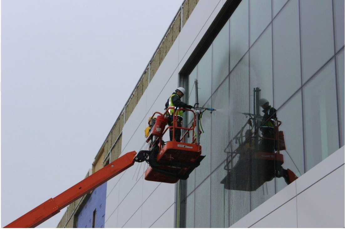
Şekil 4.71 : Su püskürtülerek sahada yapılan su sızdırmazlık testi (Url-25, 2022).
