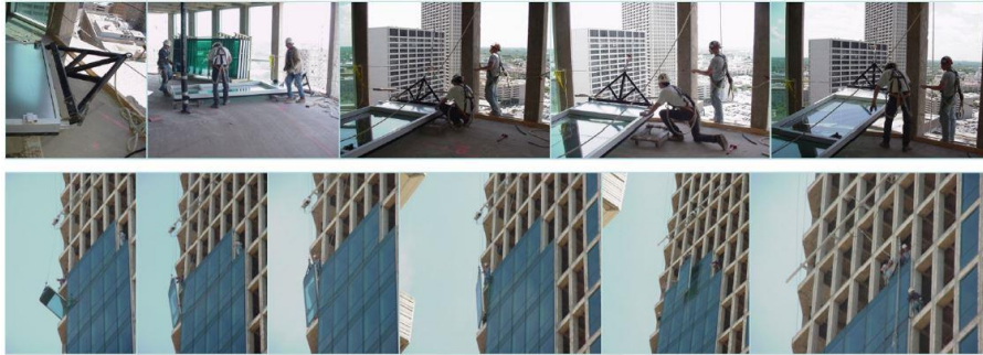
Şekil 4.66 : Bina içerisinden yapılan panel montaj aşamaları (Url-21, 2022).
