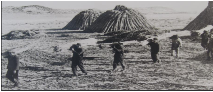
Kamış perde tesisi çalışmaları (1963 yılı)
