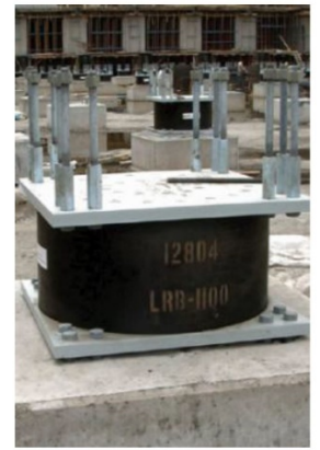
Şekil 2. 18: Erzurum Devlet Hastanesi Ve Uygulanan Sismik İzolatör (Yurdakul, 2011:27)
