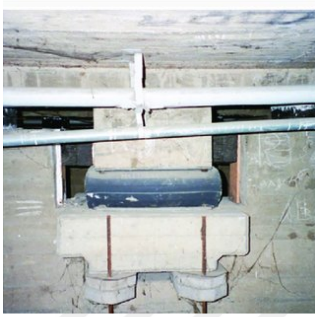
Şekil 2. 11: Pestalozzi Okulunda Kullanılan Yalıtıcılar (Naeim & Kelly, 1999).
