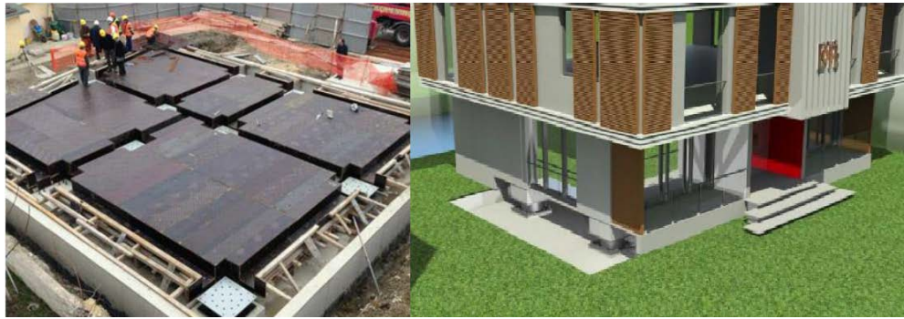
Şekil 2. 20: Aykent Loft Türkiye Sismik İzolatör Yerleşimi Ve Uygulama Modeli (Kök, 2014)
