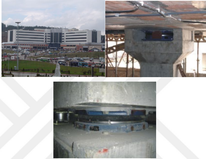
Şekil 2. 13: Kocaeli Hastanesi Sismik İzolatör Uygulaması (Kök, 2014:71)
