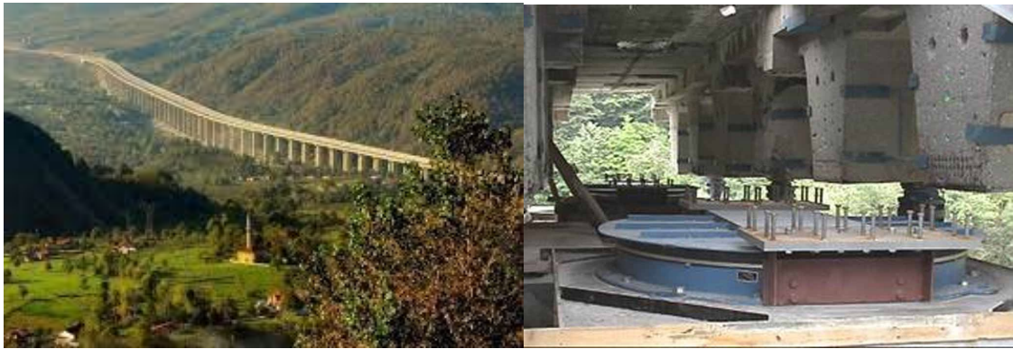
Şekil 2. 12: Bolu Viyadüğü Sürtünmeli Sarkaç İzolatör Uygulaması (Roussis, Constantinou, Erdik, Durukal, & Dicleli, 2003)
