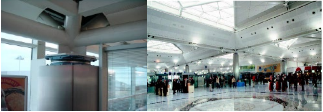
Şekil 2. 14: İstanbul Atatürk Havalimanı Sarkaç Tipi İzolatör Uygulaması (Constantinou, Whittaker, & Velivasakis, 2001)
