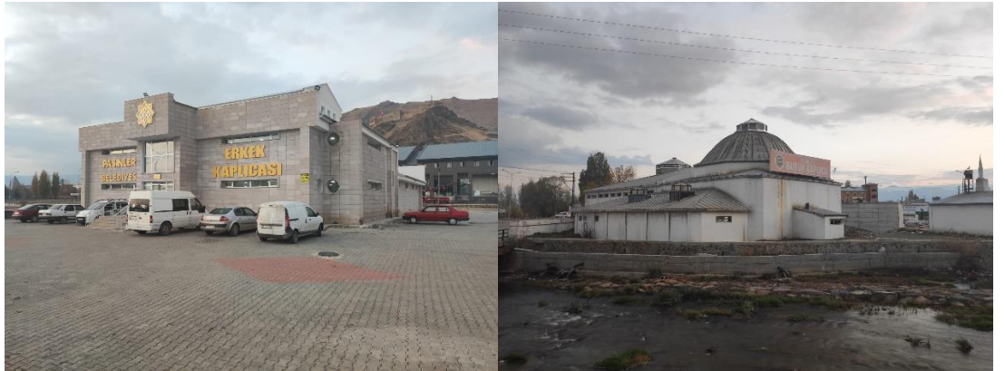
Şekil 20. Pasinler jeotermal tesisi
