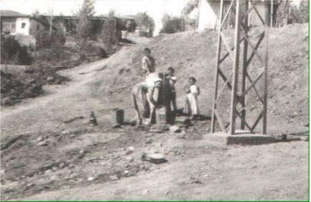
Elektrik ve su hattı çekildikten sonra mahalleden bir fotoğraf.
