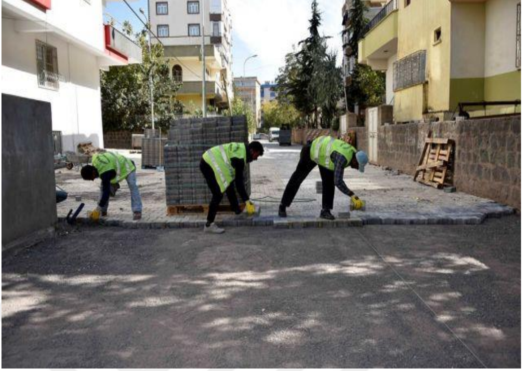
Şekil 4.53. Eyyübiye İlçesinde Zemin Döşemesi (Furkan Sincar, 2022)
