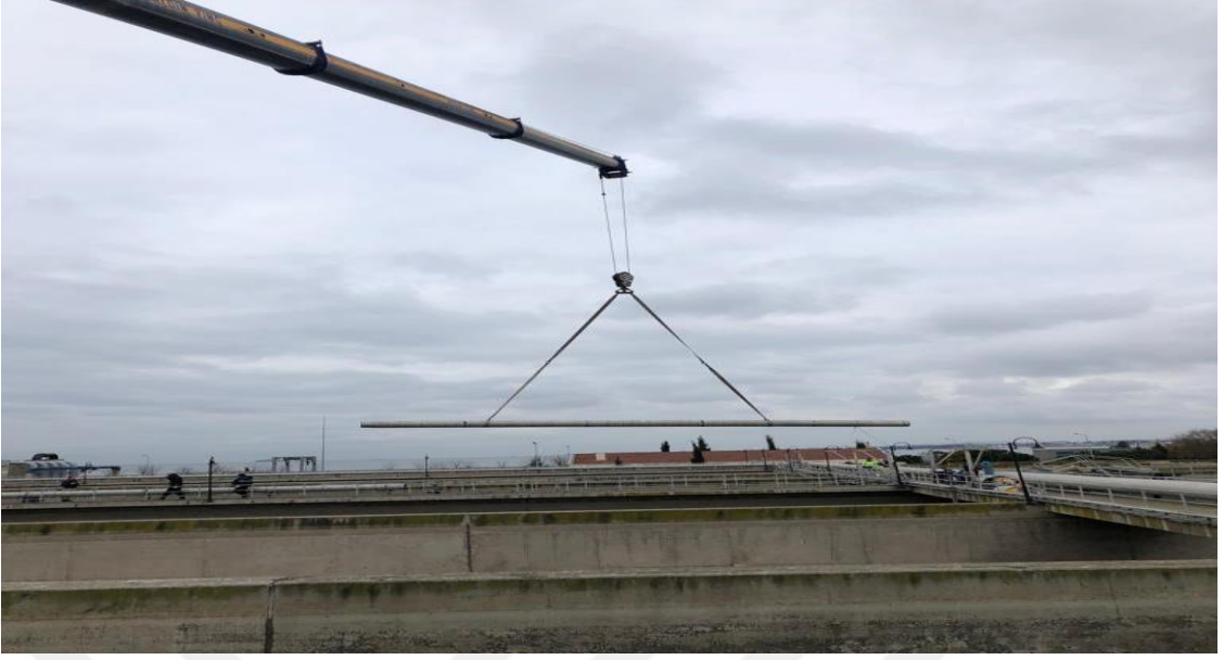
Şekil 5.5. Hava hattı borulama yapısı taşınımı.
