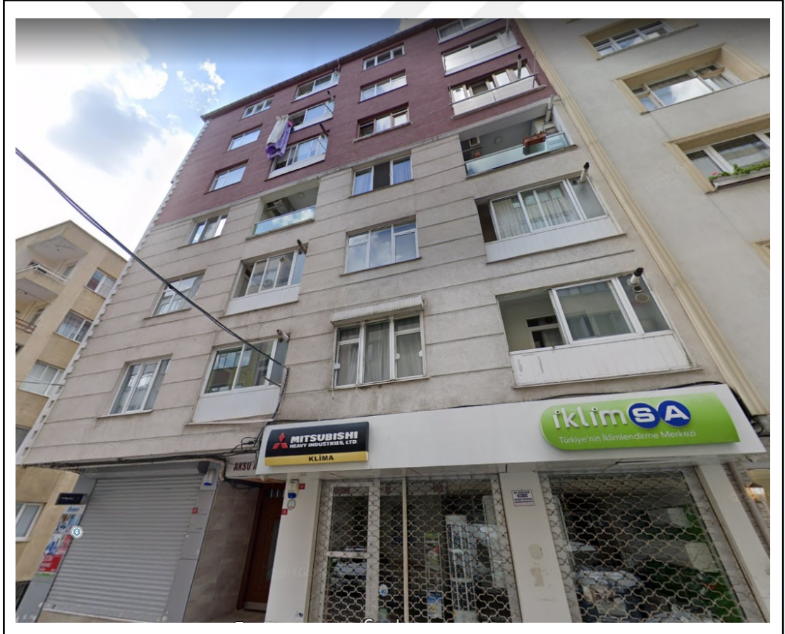
Şekil A1.7: İnceleme yapılan örnek yapı.
