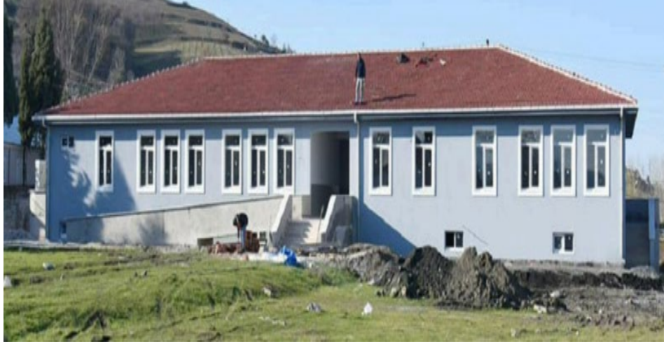
Şekil 2.5. Tekkeköy Belediyesi Okul İnşaatı
