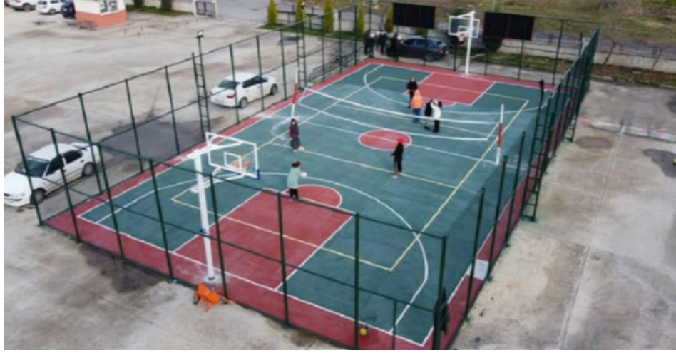
Şekil 2.11-Tekkeköy Belediyesi Okul Spor Sahası İnşaatı
