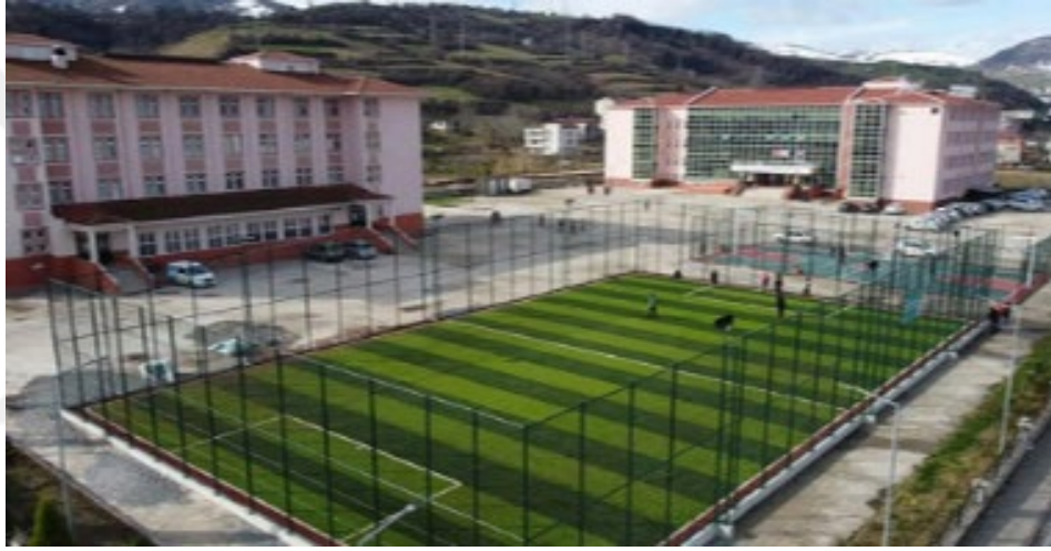
Şekil 2.9-Tekkek y Belediyesi Okul Spor Sahası İnşaatı
